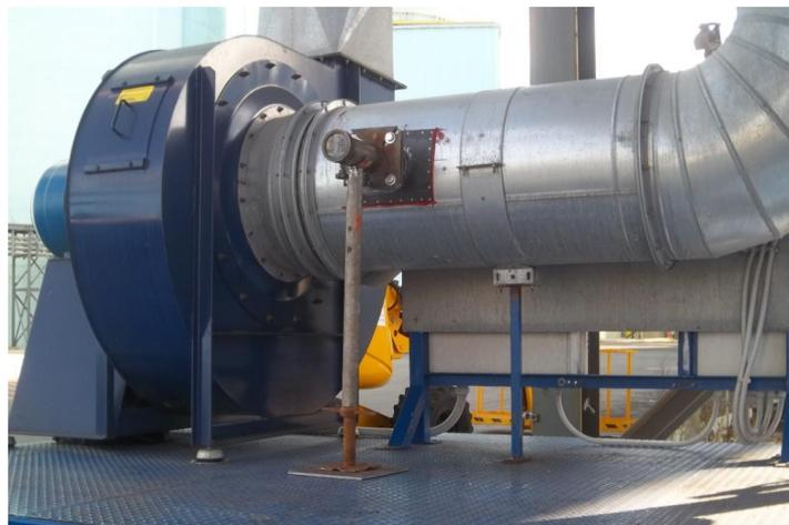
Figura 8 - Bocchello di attacco della sonda di prelievo per le misure delle emissioni all'uscita del filtro a manica.
