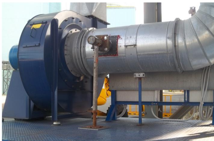
Figura 2 - Bocchello di attacco della sonda di prelievo per le misure delle emissioni all'uscita del filtro a manica.
