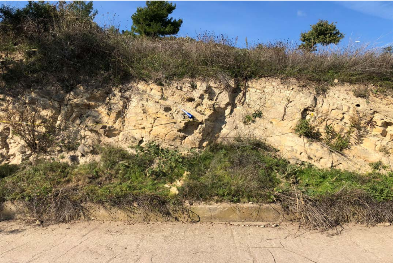
FOTO POSTAZIONE DEL RILIEVO GEOMECCANICO
