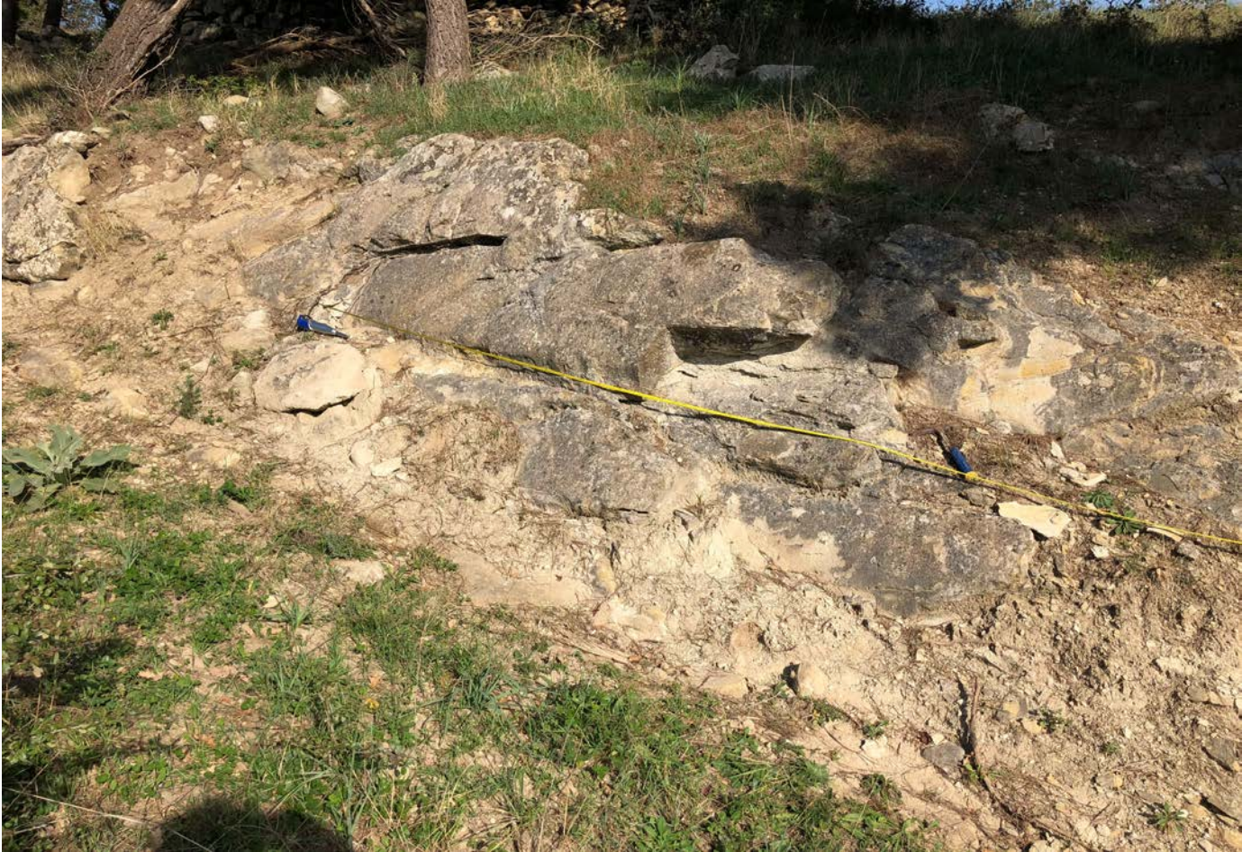
FOTO POSTAZIONE DEL RILIEVO GEOMECCANICO
