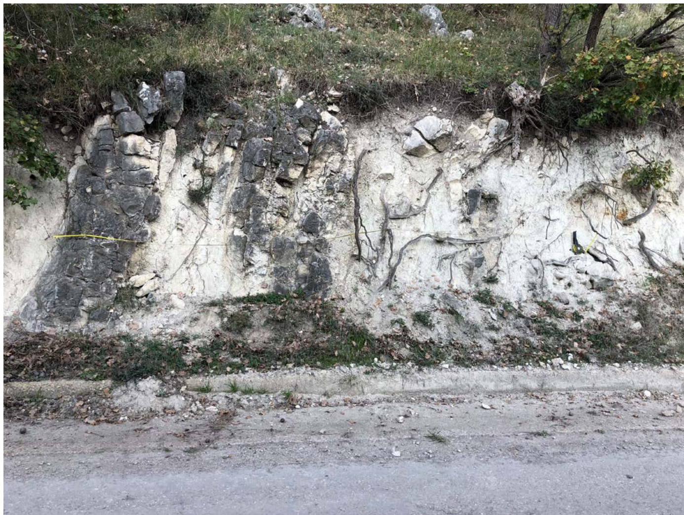
FOTO POSTAZIONE DEL RILIEVO GEOMECCANICO
