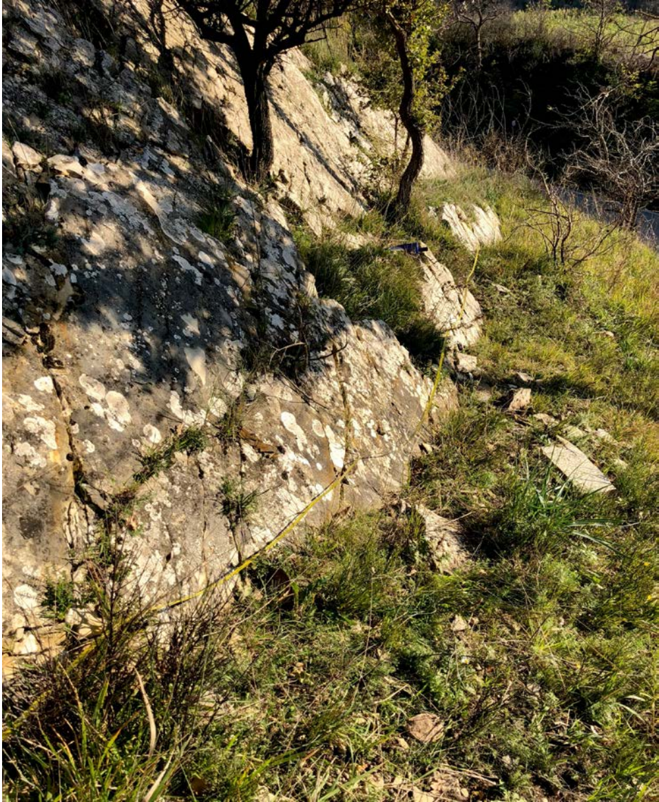
FOTO POSTAZIONE DEL RILIEVO GEOMECCANICO
