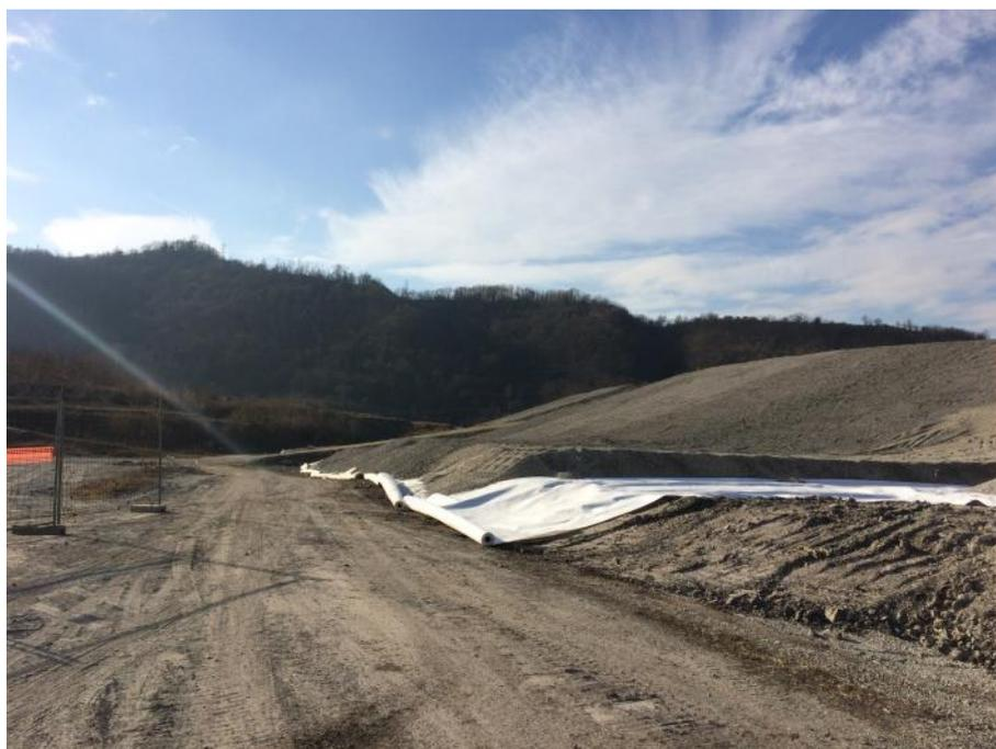
Figura 4-53: Predisposizione del primo strato di sabbia ghiaiosa sul materiale abbancato (1)
