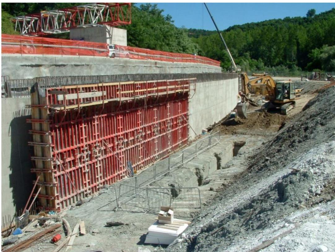
**Figura 4-17: Muri di fondazione tipologia 3 – luglio 2005 (si osserva la consistenza litoide del substrato marnoso)**
