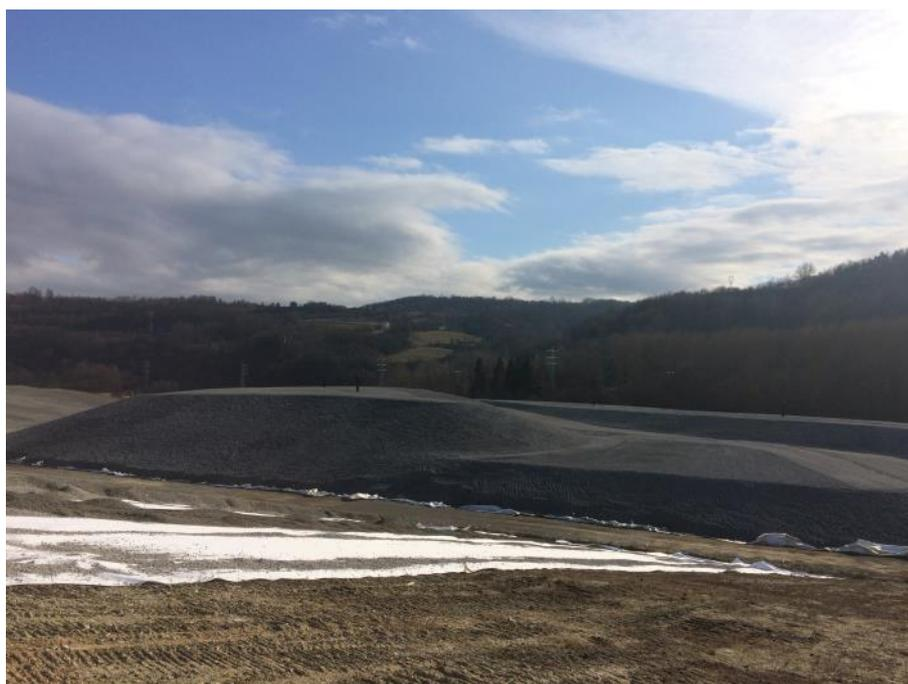
Figura 4-54: Predisposizione del primo strato di sabbia ghiaiosa sul materiale abbancato (2)
