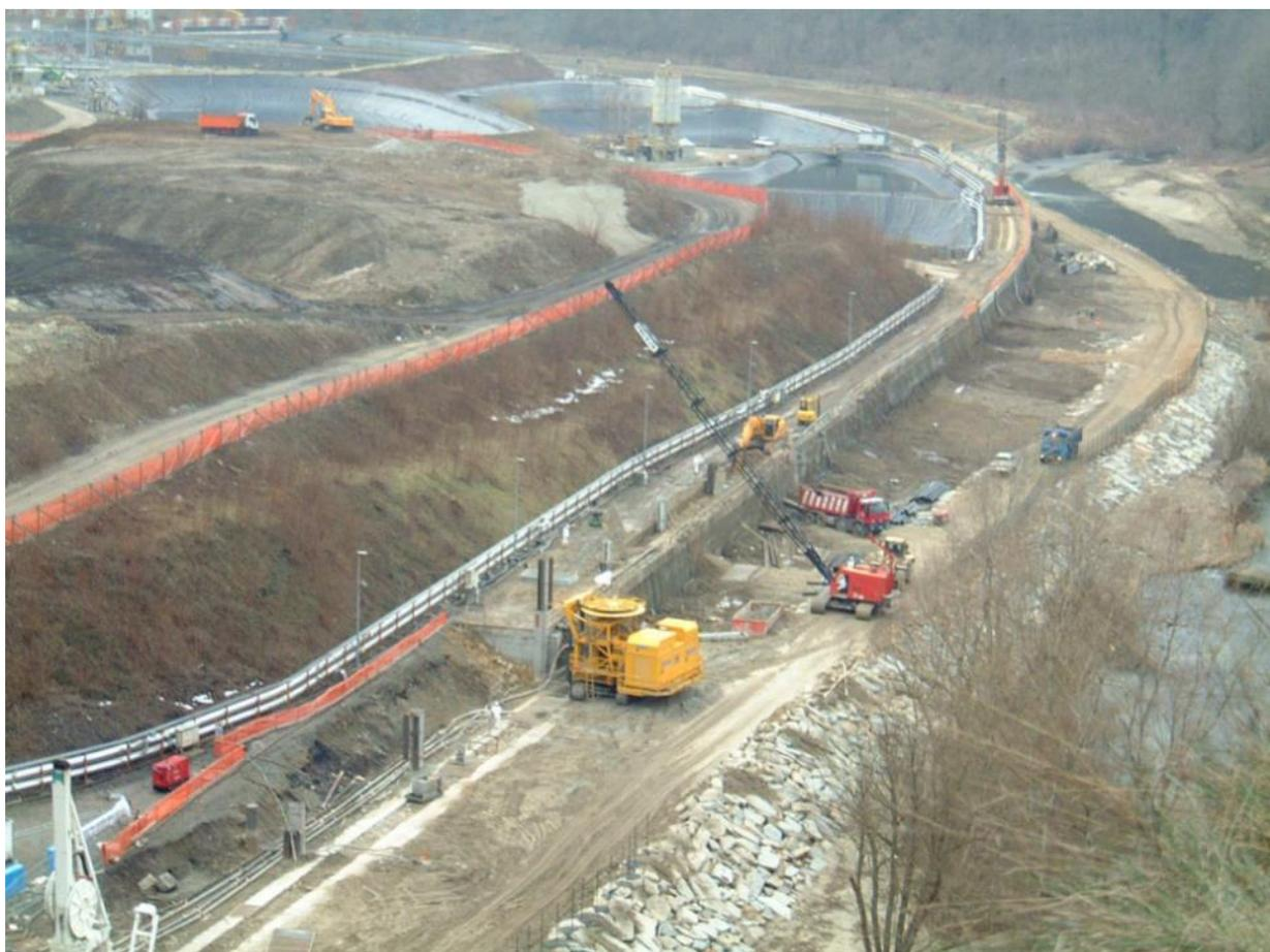
**Figura 4-13: Realizzazione del diaframma plastico tipologia 1A (febbraio 2004)**
