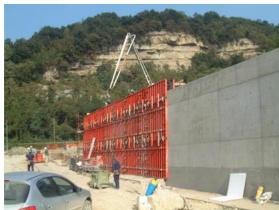
**Figura 4-10: Fasi di realizzazione delle opere arginali di contenimento delle piene del fiume Bormida e di contenimento e drenaggio delle acque di falda interne**
