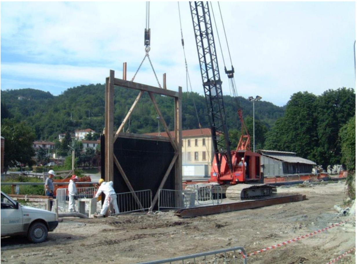
**Figura 4-20: Posa in opera telo HDPE diaframma plastico tipologia 5 zona E (luglio 2004)**
