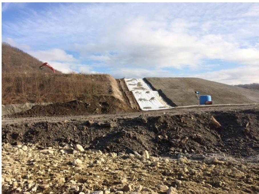
**Figura 4-47: riprofilatura con fronti di scavo max 30 m**
