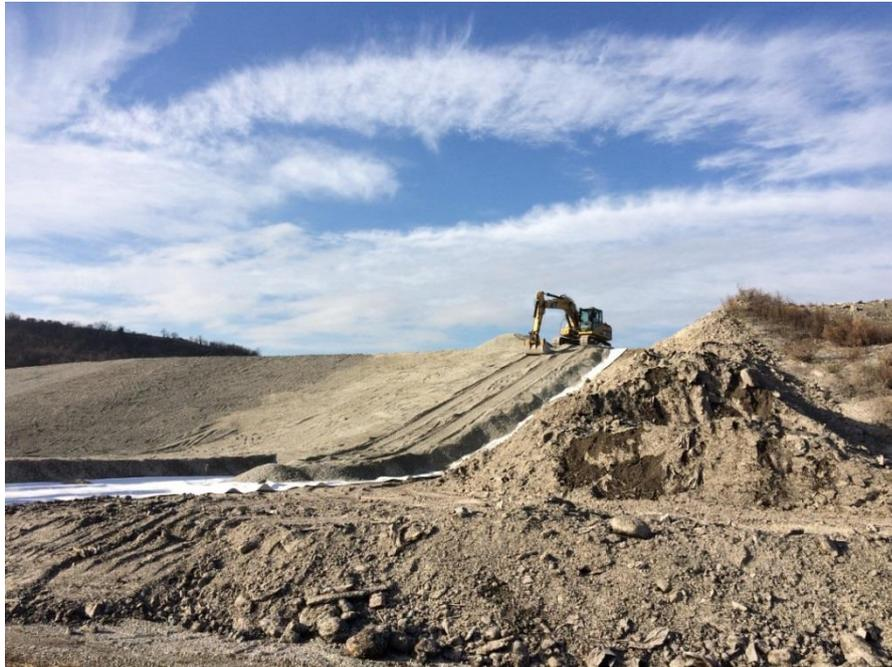
**Figura 5-19: Operazioni di realizzazione del capping (1)**
