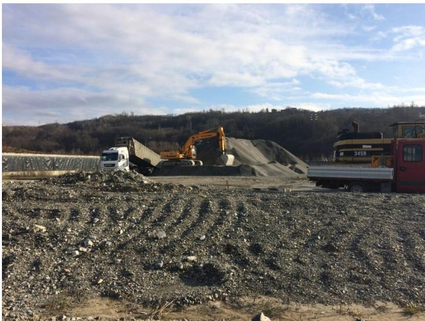
Figura 5-17: Operazioni di stoccaggio e carico materiali per la formazione del *capping* in Zona A1
