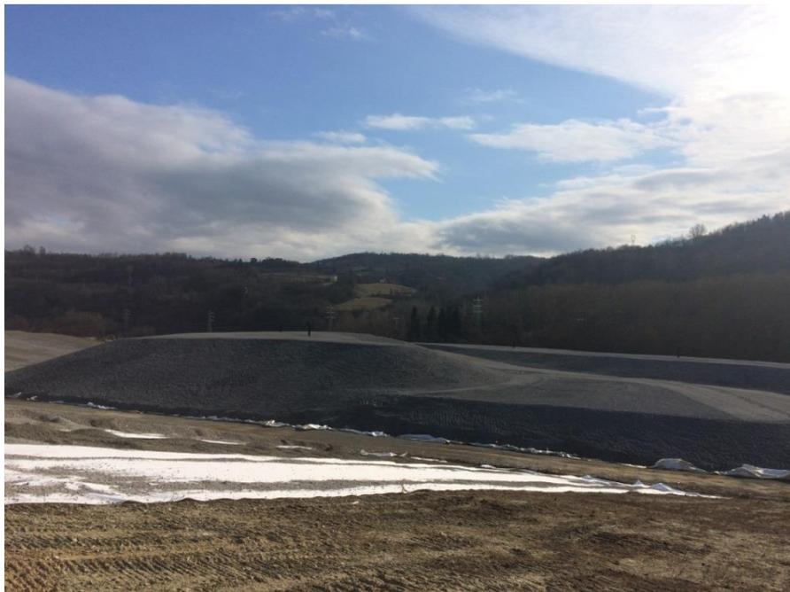
**Figura 5-20: Operazioni di realizzazione del capping (2)**
