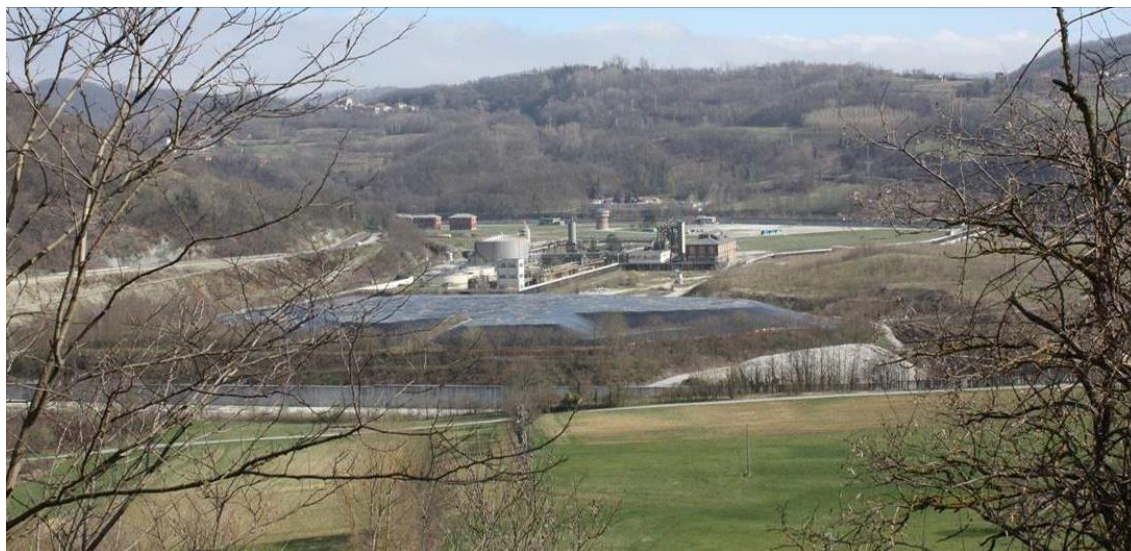
Figura 5-6: Vista del Sito dal nucleo di Brignoletta a NordOvest dell'area – anno 2015
