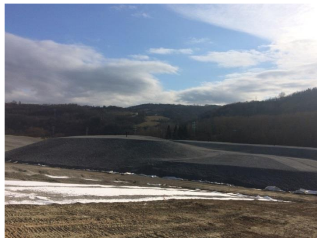
Figura 5-3: Operazioni di completamento del capping in Zona A1
