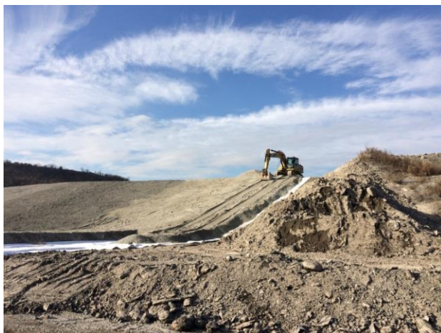
Figura 5-3: Operazioni di completamento del capping in Zona A1
