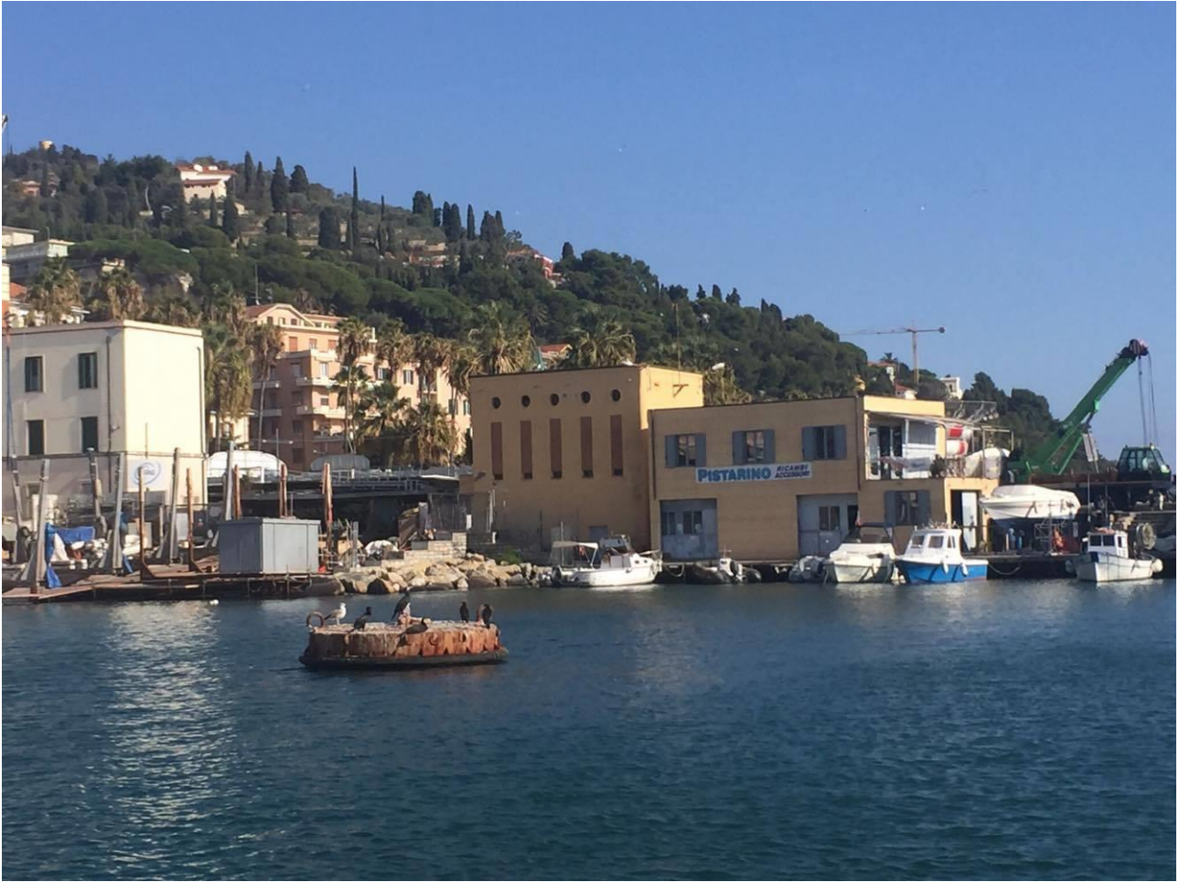
Foto 3: fronte ovest dal mare e vista d'insieme del contesto
