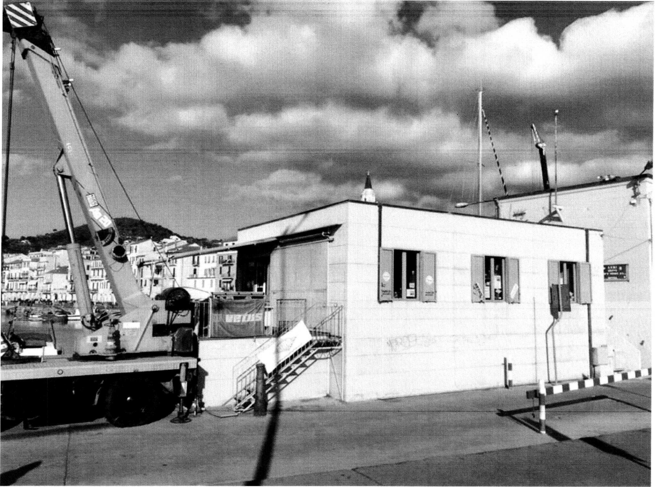
Foto 2: fronte sud e fronte est
