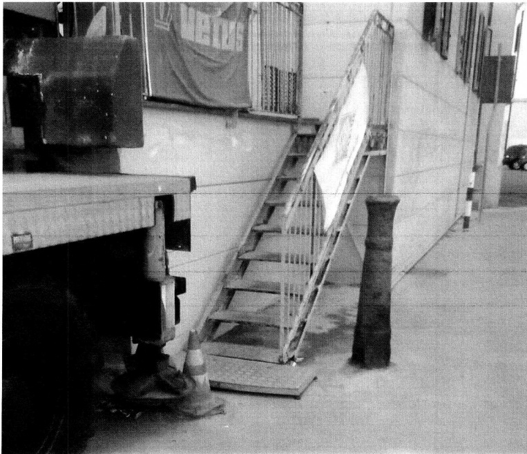
Particolare della scala esterna
