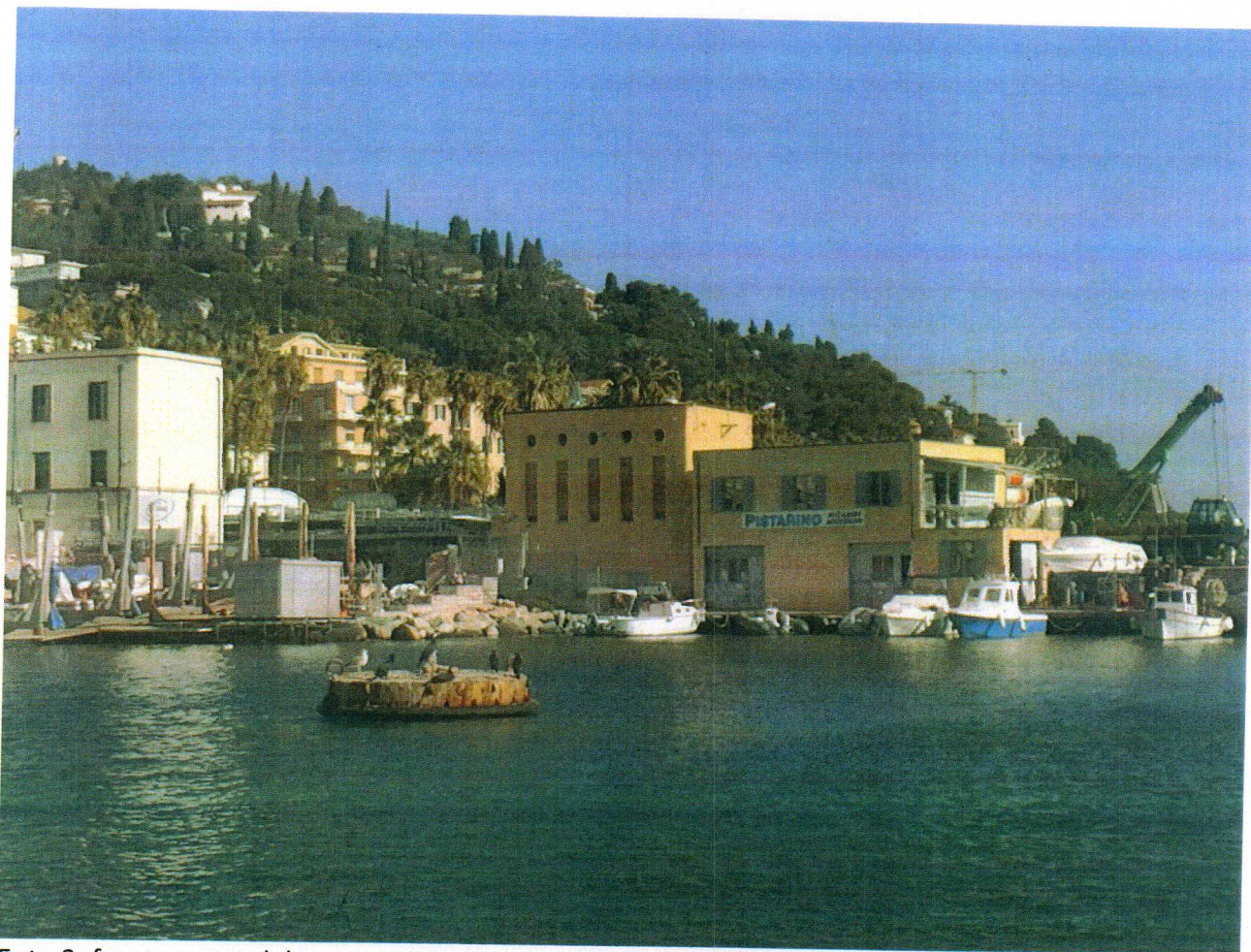
Foto 3: fronte ovest dal mare e vista d'insieme del contesto
