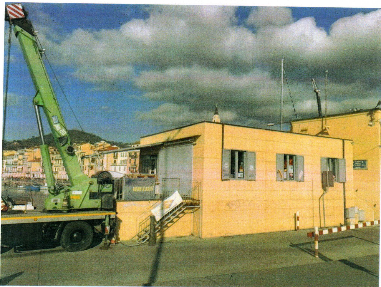
Foto 2: fronte sud e fronte est
