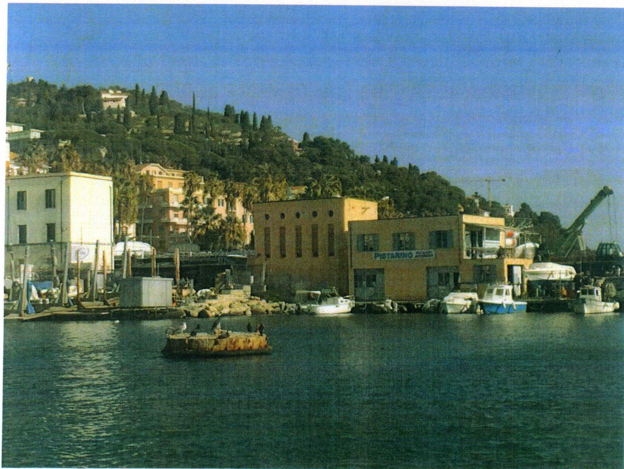
Foto 1: vista del fronte ovest: al piano terra non è stato realizzato il portale centrale
