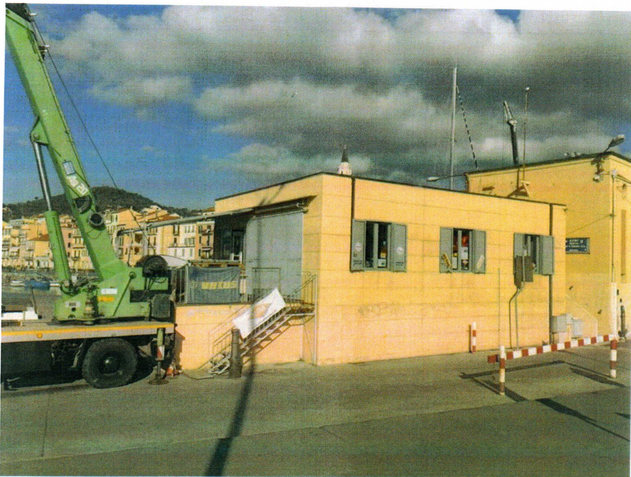
Foto 2: vista della scala metallica di accesso al piano primo
