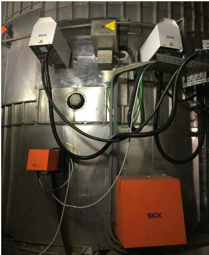
Figura 8 Tipica installazione sonde di prelievo (SME principale e backup) in grigio, il polverimetro con il gruppo di soffiaggio in arancio
