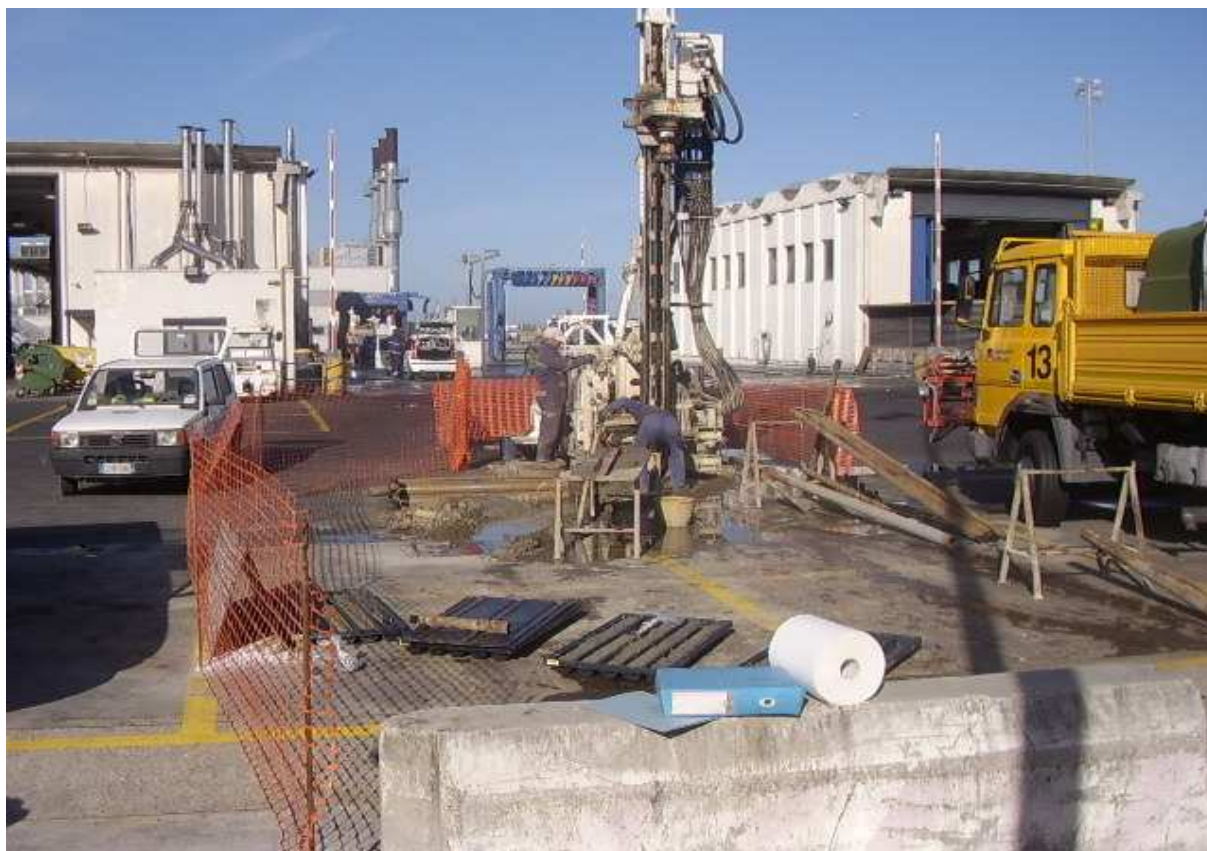
SONDAGGIO S1 - POSTAZIONE
