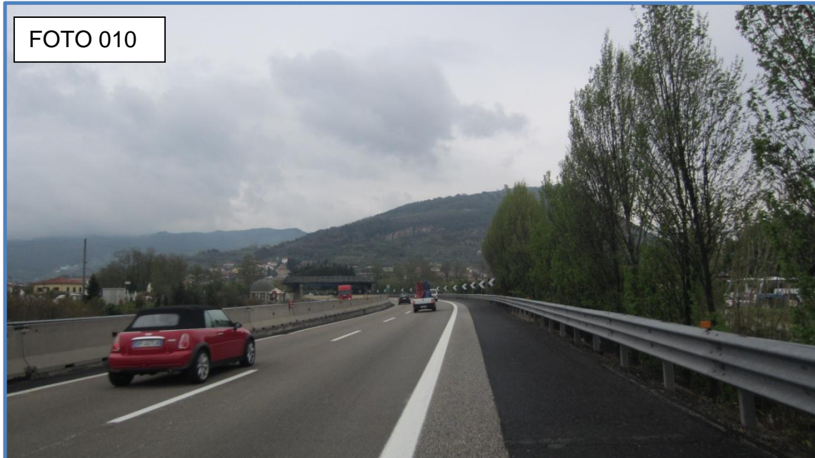
Foto 010 Presenza fotografica dalla sede autostradale alla progressiva Km 38+100. L'immagine è stata utilizzata per il foto inserimento.
