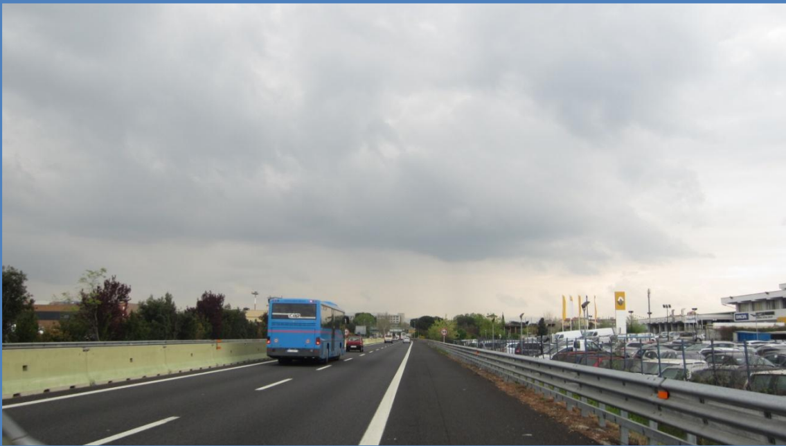
Foto 050 Paesaggio industriale nella zona di Osmannoro da sedime autostradale. Il fotogramma è stato utilizzato per il foto inserimento alla progressiva Km 0+630.
