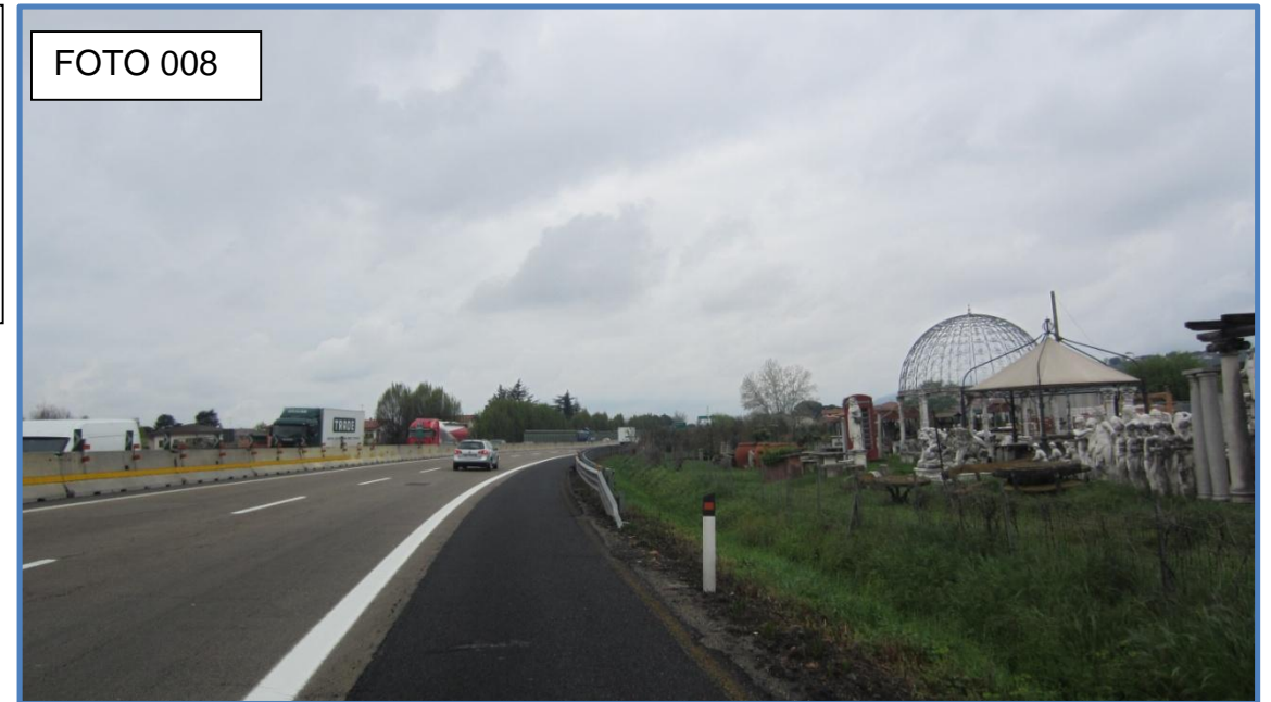
Foto 008 Presenza fotografica dalla sede autostradale alla progressiva Km 37+500. L'immagine è stata utilizzata per il foto inserimento.
