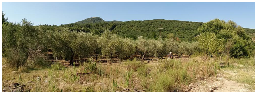
Figura 7-3 Vista dell'area in cui si inserisce il cantiere AT.01
