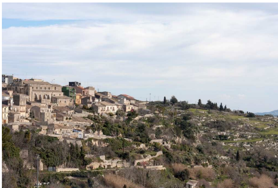
Punto di vista 4 – Stato di fatto
