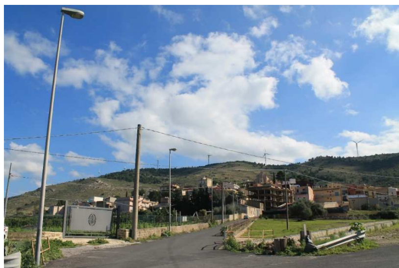
Punto di vista 1 – Stato di fatto
