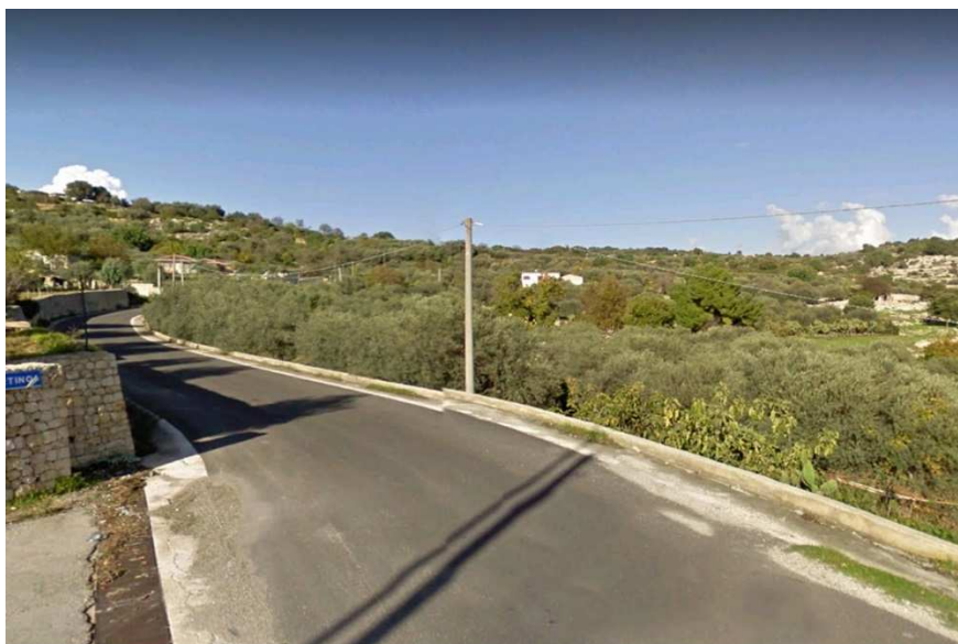
Punto di vista 7 – Stato di fatto
