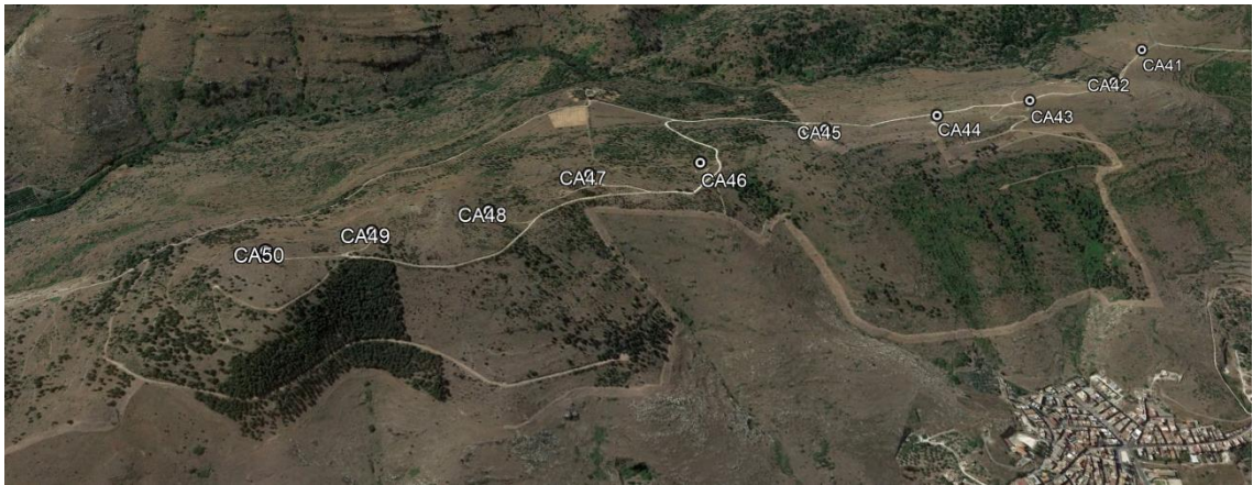
Figura 4: Inquadramento del sito, Carlentini I, vista da Nord-Ovest
