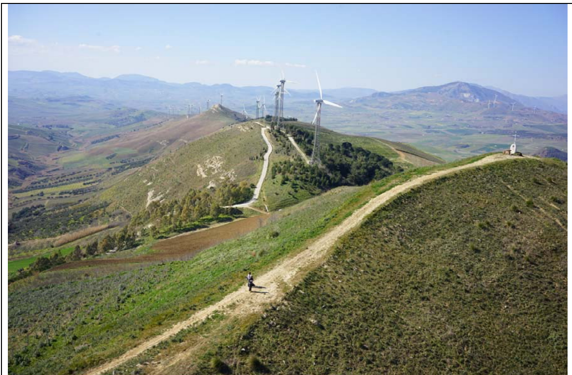
Panoramica del parco eolico esistente acquisita con Drone – fonte HE
