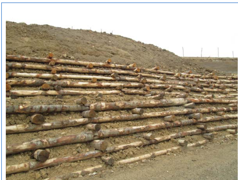
Esempio di opera in palificate in legname - Fonte HE
