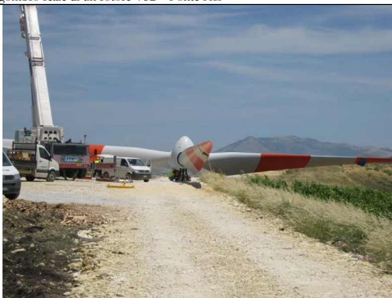
Particolare del supporto in acciaio su cui è collocato il rotore – Fonte HE
