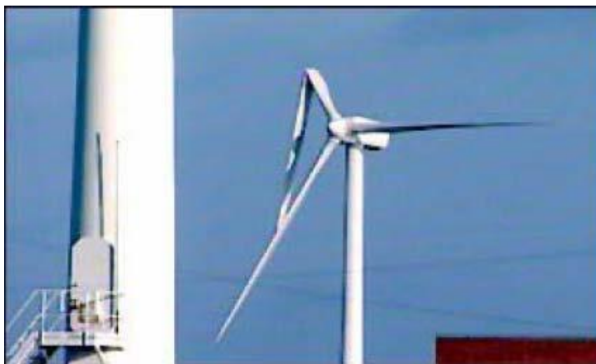
Esempio di rottura di pala senza distacco.
