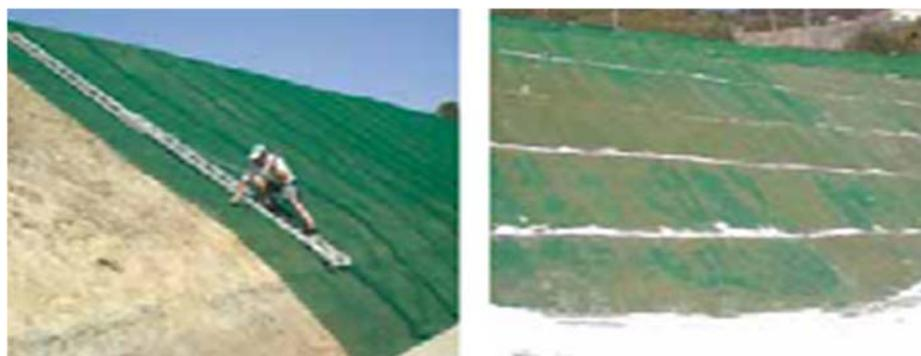
Le geocelle sono dei geosintetici a struttura alveolare flessibili, resistenti e leggeri; vengono utilizzate come sistemi di stabilizzazione corticale per impedire lo scivolamento e l'erosione di strati di terreno di riporto su forti pendenze.
