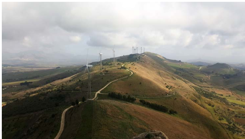
Figura 2. Il campo eolico esistente. Foto da Monte Pietroso in direzione est
