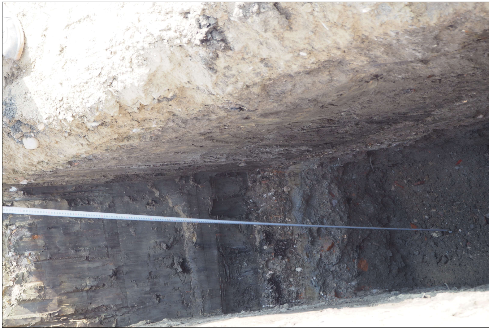
Sezione trincea realizzata
