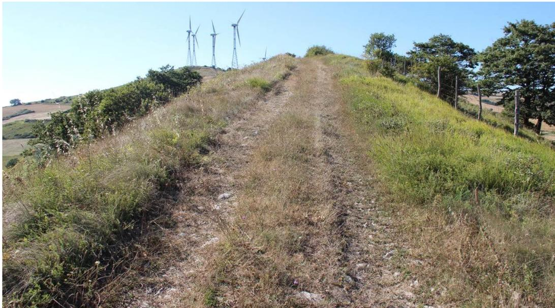
**Figura 10:** tratto di strada esistente di collegamento tra la postazione dell'aerogeneratore R-MA02 e R-MA03. La strada andrà realizzata ex novo.
