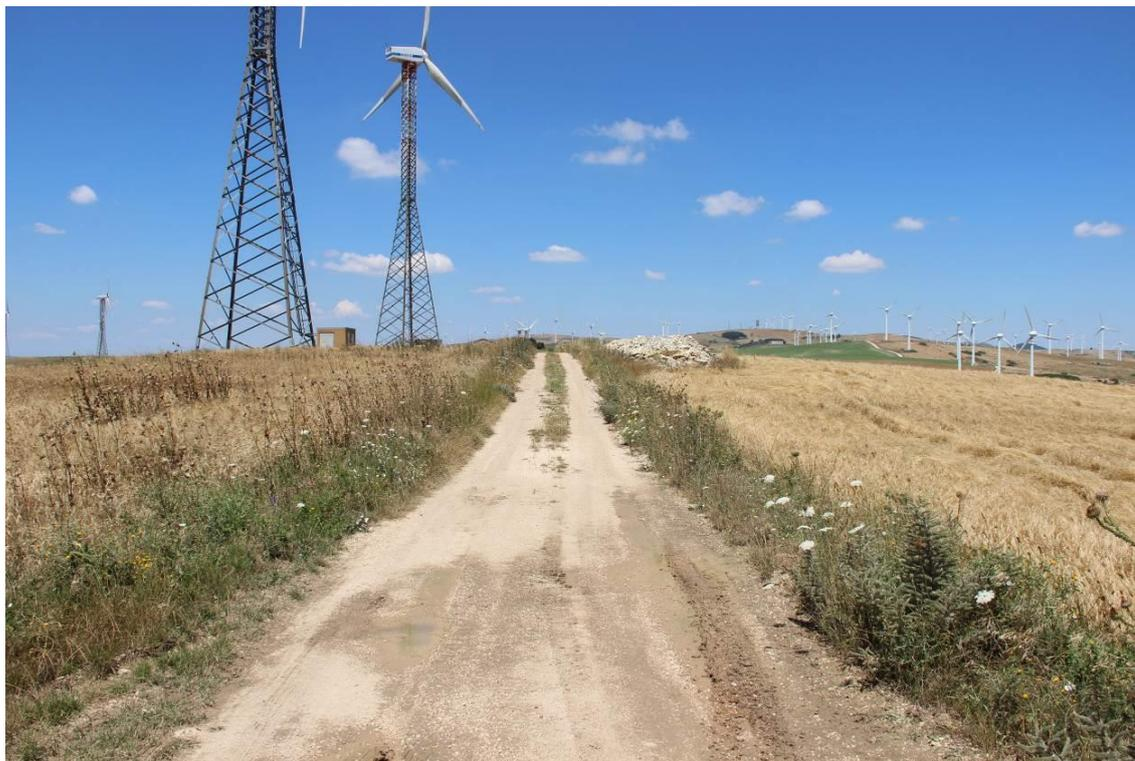
**Figura 11:** tratto di strada che serve l'impianto esistente in prossimità della nuova posizione R-GR06: la strada avrà bisogno esclusivamente di interventi minimi di allargamento della sede carrabile e di ricarica puntuale con stabilizzato di cava.
