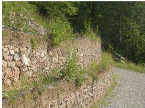
**Figura 8** - Esempi di utilizzazione delle gabbionate con tasche vegetative rinverdibili
