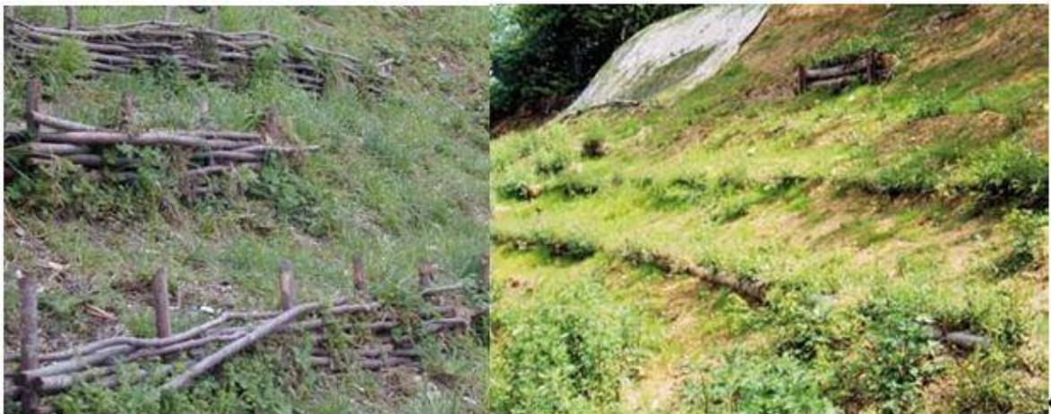
**Figura 9** - Esempi di utilizzazione delle vimate (a sinistra) e delle cordate (a destra) su versanti
