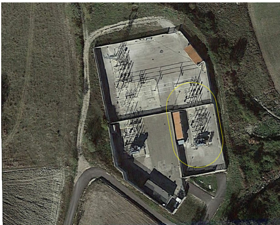
Figura 7 – Indicazione della DPA (in giallo) con sovrapposizione su ortofoto per la sottostazione di Celle San Vito
