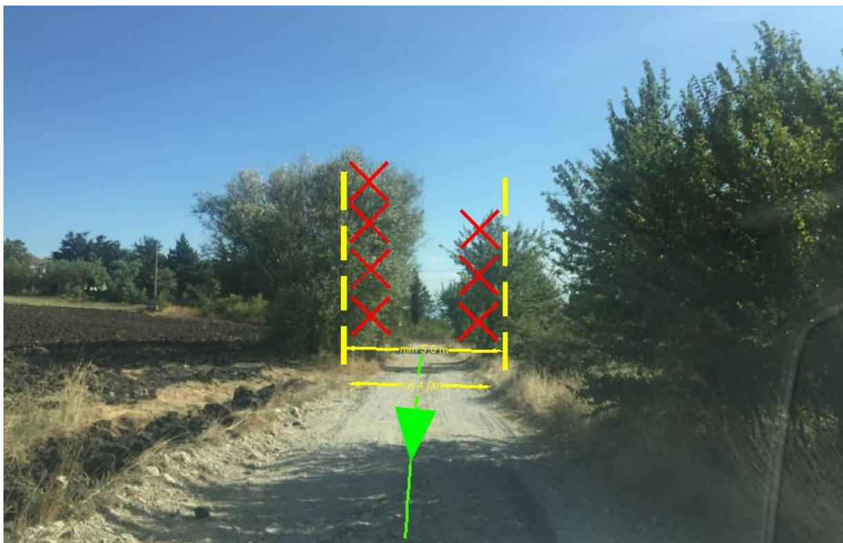
Figura 31: Ob14 È necessario rendere la strada percorribile per almeno 4 metri di larghezza e almeno 5 metri di altezza.
