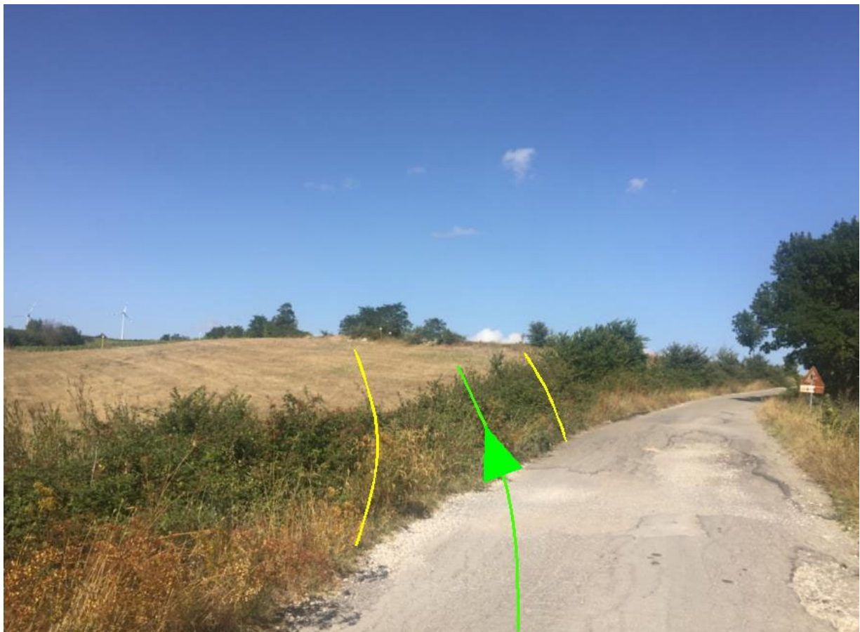
Figura 45: Ob21 creare By-pass, verificato in fase di sopralluogo.
