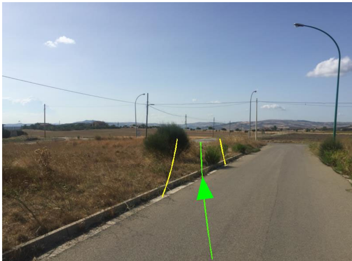
Figura 13: Ob 05 creare By-pass come mostrato, verificato in fase di sopralluogo.
