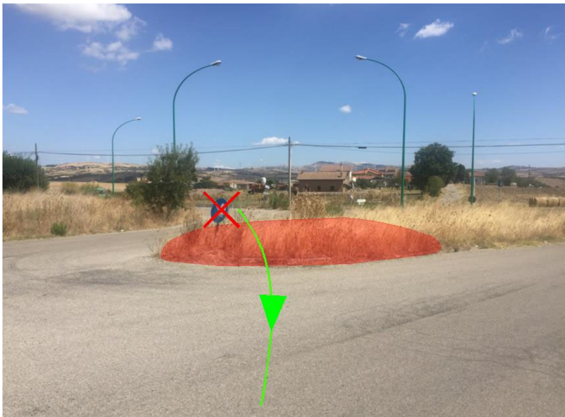
Figura 7: Ob02 rimozione dell'isola di traffico e i segnali stradali così come mostrato.
