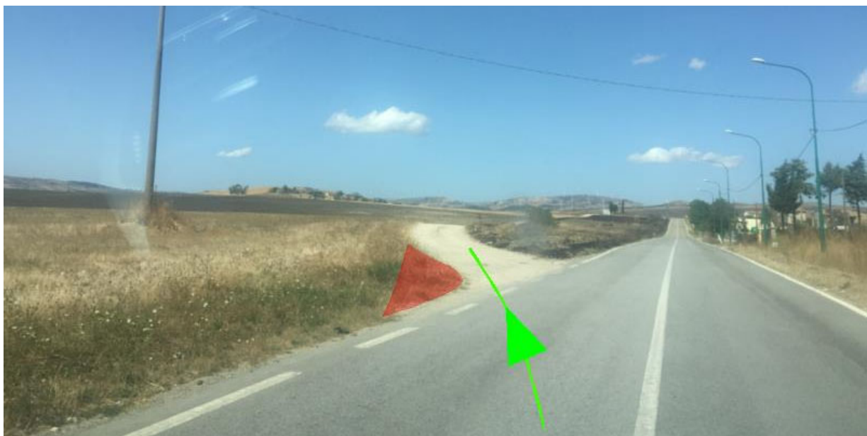
Figura 17: Ob 07 eseguire ingrandimento sul margine sinistro e creare le strade secondo specifiche del fornitore degli aerogeneratori.
