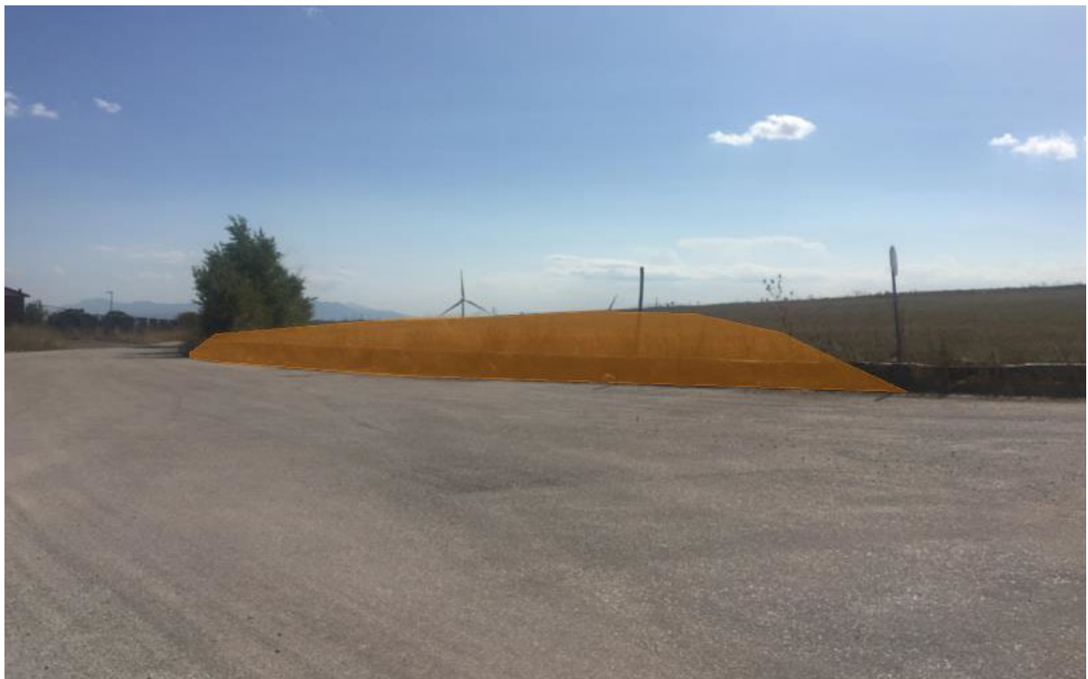
Figura 49: Ob23 Area di ricarica per Tower, Nacelle e Blade, da questa osservazione è necessario utilizzare semirimorchi speciali e alza-lama (blade lifter).
