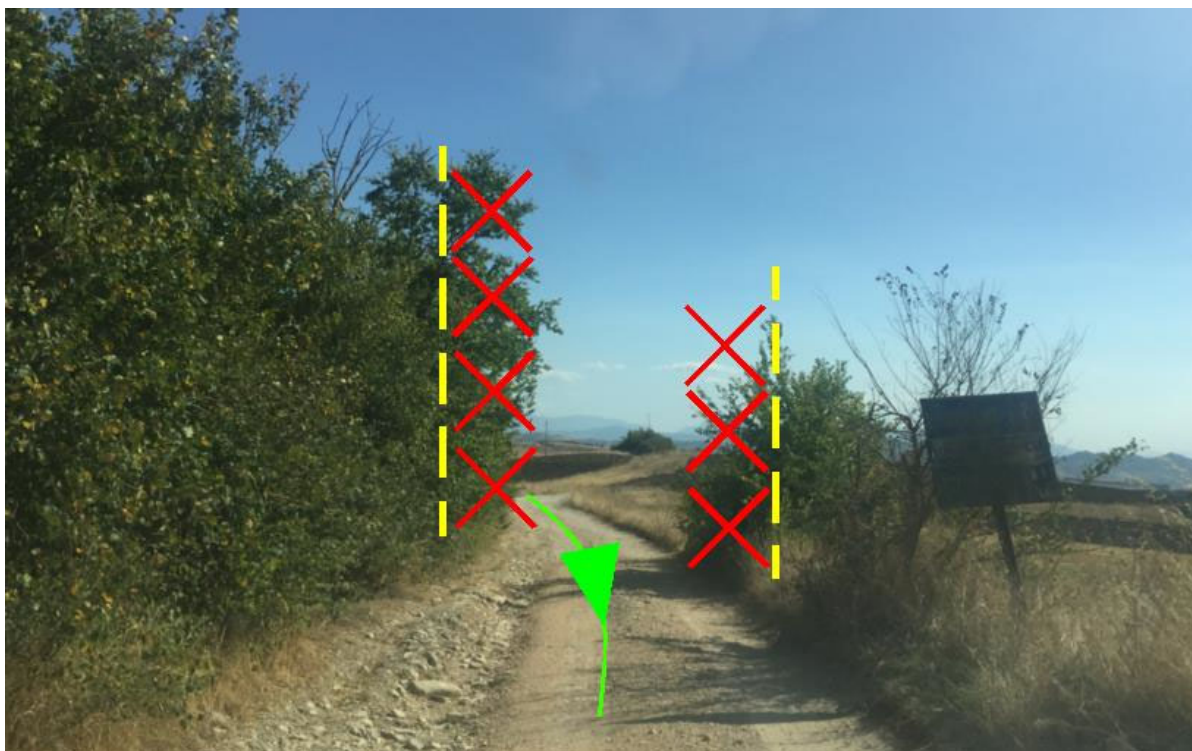
Figura 29: Ob13 Lungo l'intero percorso rimuovere la vegetazione che sporge sul ciglio della strada
