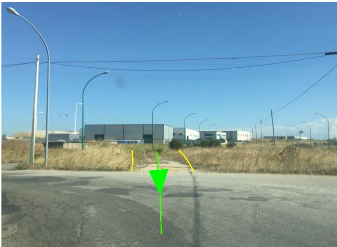
Figura 15: Ob 06 fine By-pass, verificato in fase di sopraluogo.
