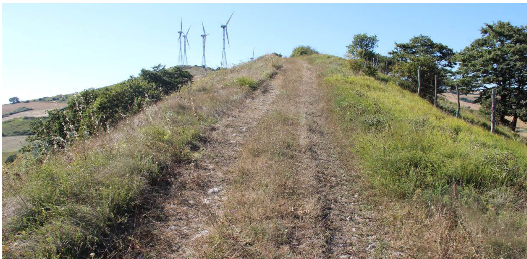
Figura 1: tratto di strada esistente di collegamento tra la postazione dell'aerogeneratore R-MA02 e R-MA03. La strada andrà realizzata ex novo.
