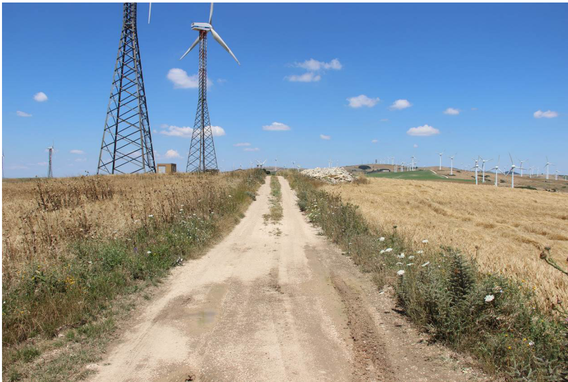
Figura 2: tratto di strada che serve l'impianto esistente in prossimità della nuova posizione R-GR06: la strada avrà bisogno esclusivamente di interventi minimi di allargamento della sede carrabile e di ricarica puntuale con stabilizzato di cava.
