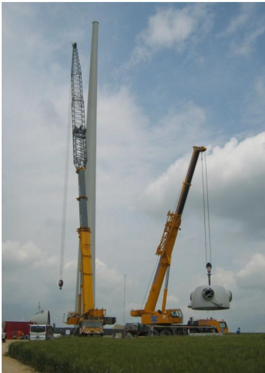
Figura 5: smontaggio navicella
