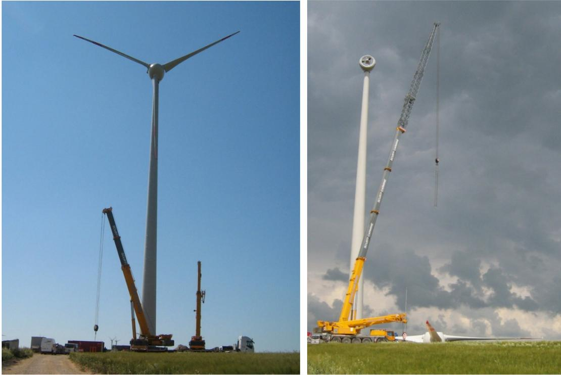
Figura 4: rimozione eliche e mozzo
