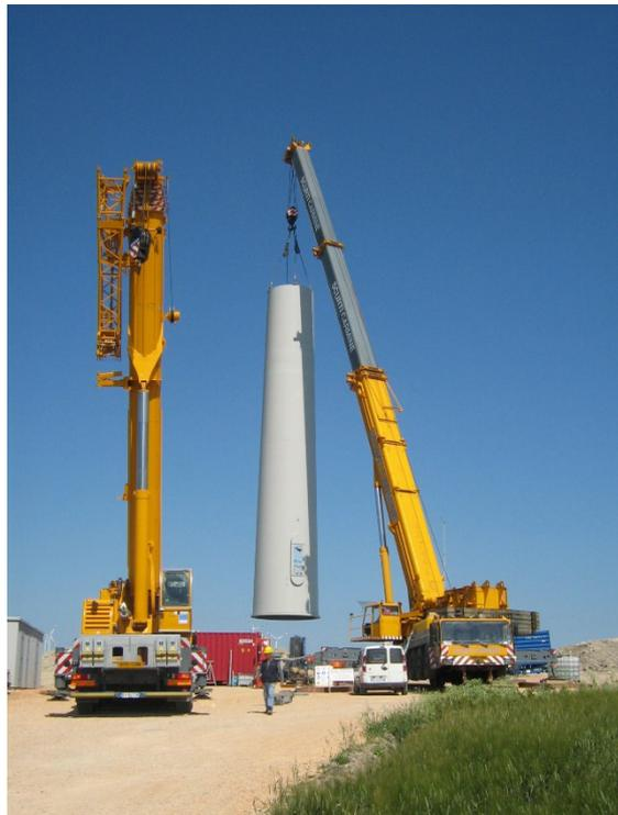
Figura 6: particolare smontaggio torre
