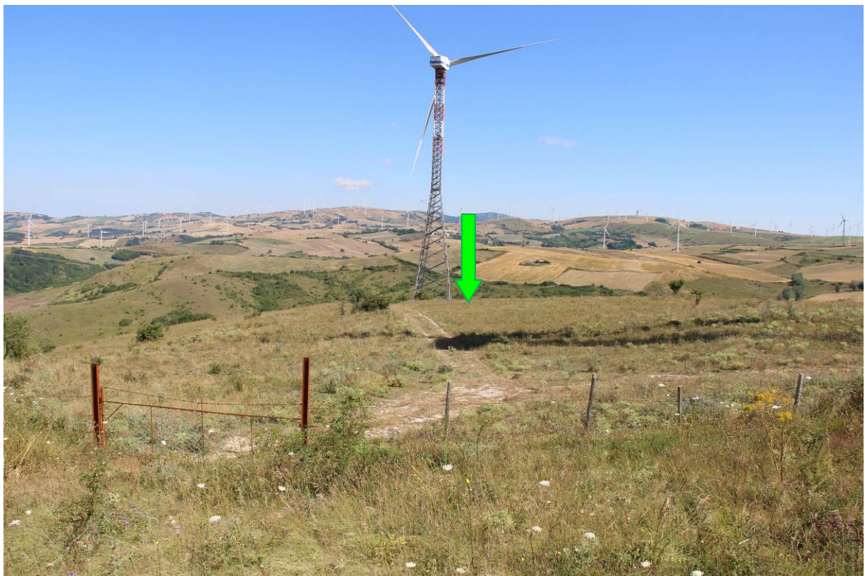
FOTO 4. POSIZIONE AEROGENERATORE R-GR03 SUL FONDO DELLA SCARPATA E ALLE SPALLE DELLA TORRE ESISTENTE GR10
