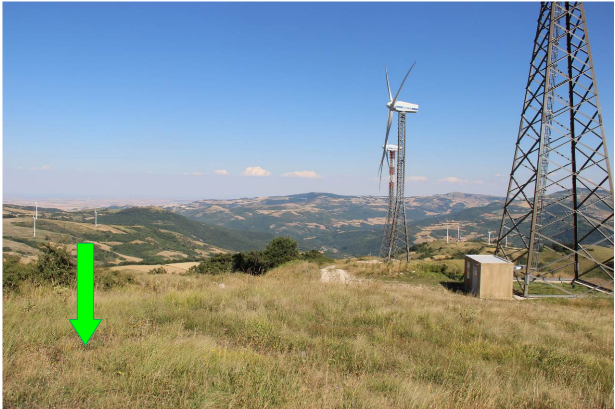
FOTO 11. POSIZIONE AEROGENERATORE R-MA03 SU TRATTO PIANO TRA LE TORRI ESISTENTI MA04 e MA03
