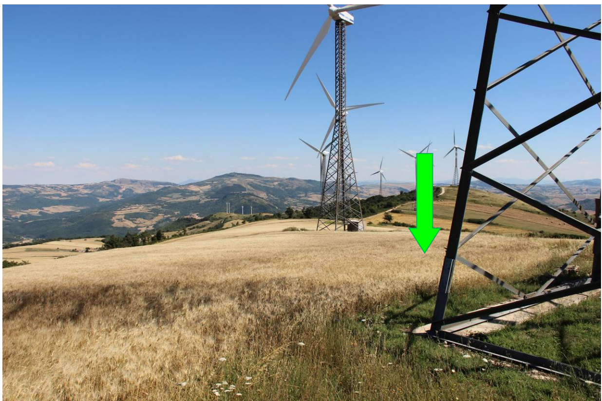
FOTO 8. POSIZIONE AEROGENERATORE R-MA05 A LATO DELLA TORRE ESISTENTE MA09
