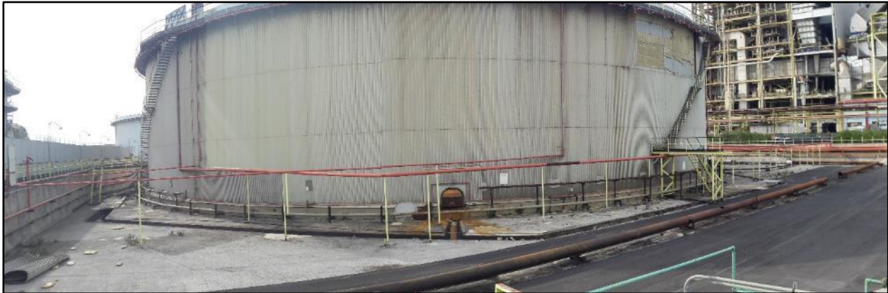
Figura 3.1.1g Ripresa fotografica da PV6
