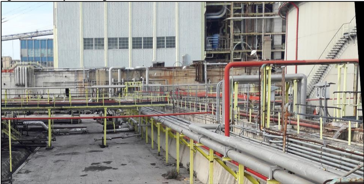
Figura 3.1.1e Ripresa fotografica da PV4
