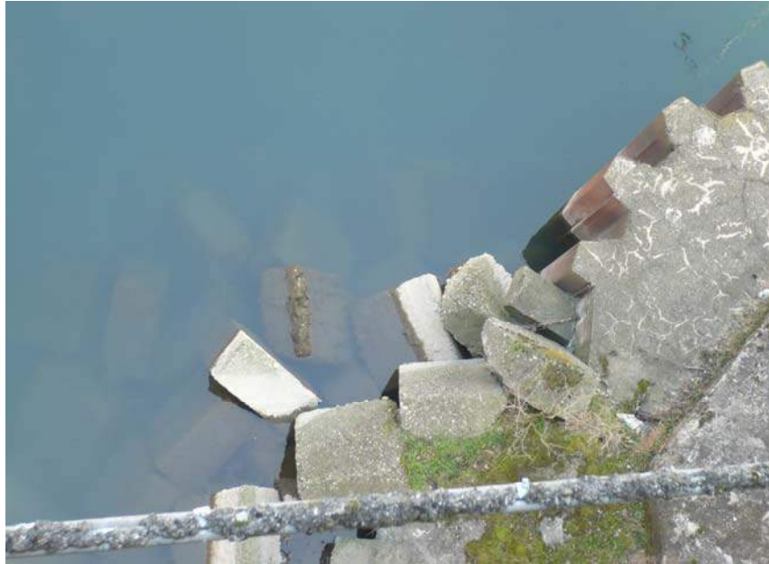
Fig. 2.2.9 – Massi ciclopici in calcestruzzo a difesa della base delle pile del ponte storico
