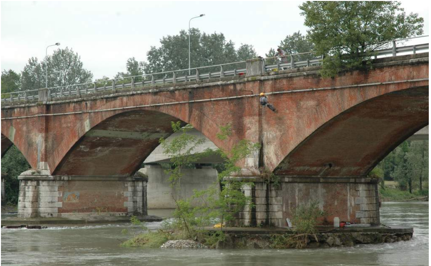
Ripresa fotografica della calata alla base della pila 2
