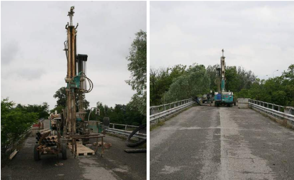
Figura 1. Esecuzione del sondaggio a carotaggio continuo S1, diametro 100mm con sonda geotecnica.
