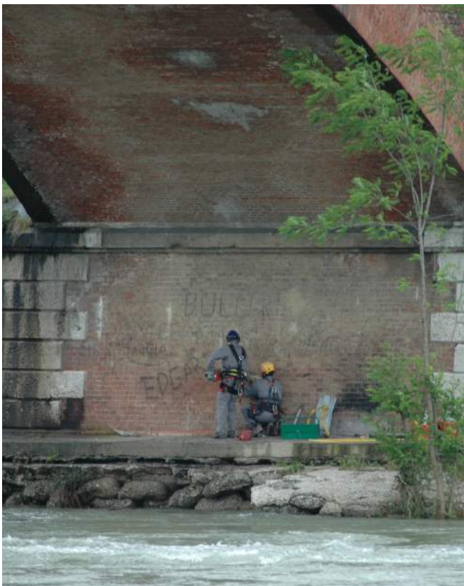
Fasi di esecuzione del carotaggio C1 alla base della pila 2
