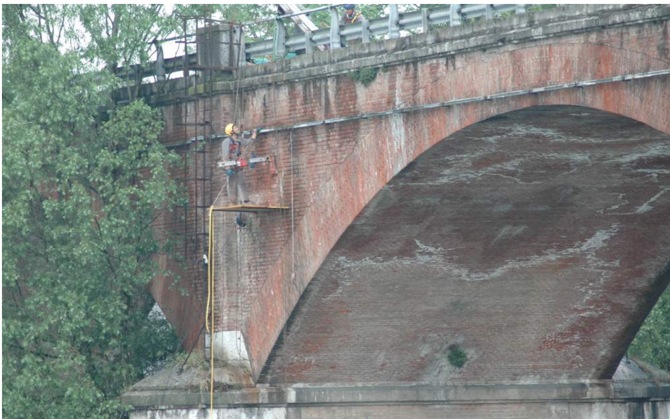
Fasi di esecuzione del carotaggio C4
