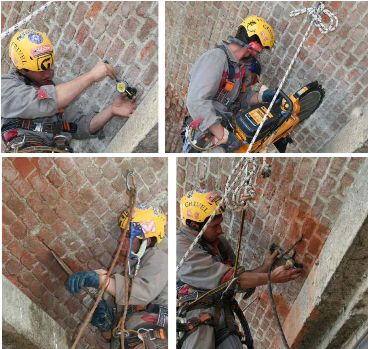
Figura 5. Fase di esecuzione della prova con martinetto piatto con l'assistenza di rocciatori
