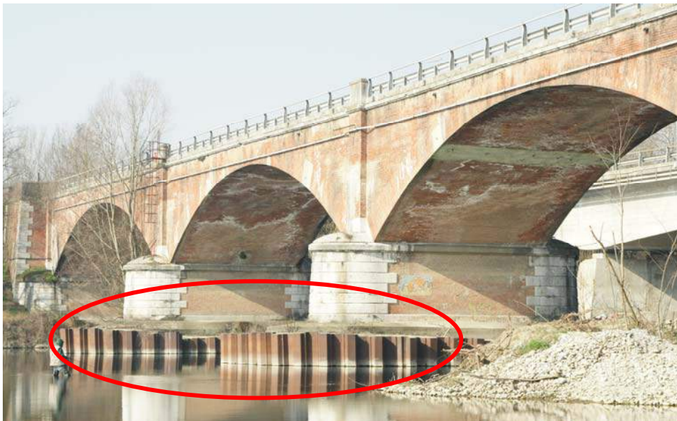
Fig. 2.2.7 – Consolidamento delle pile 3 e 4 mediante palancole.
