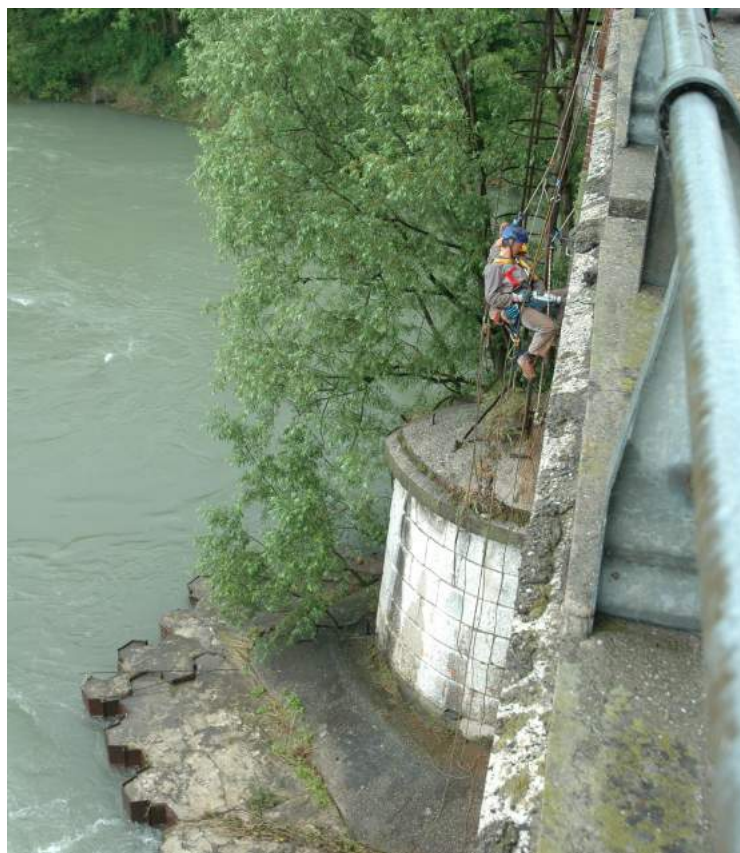
Fasi preparatorie per l'esecuzione del carotaggio C4 nella pila 4
