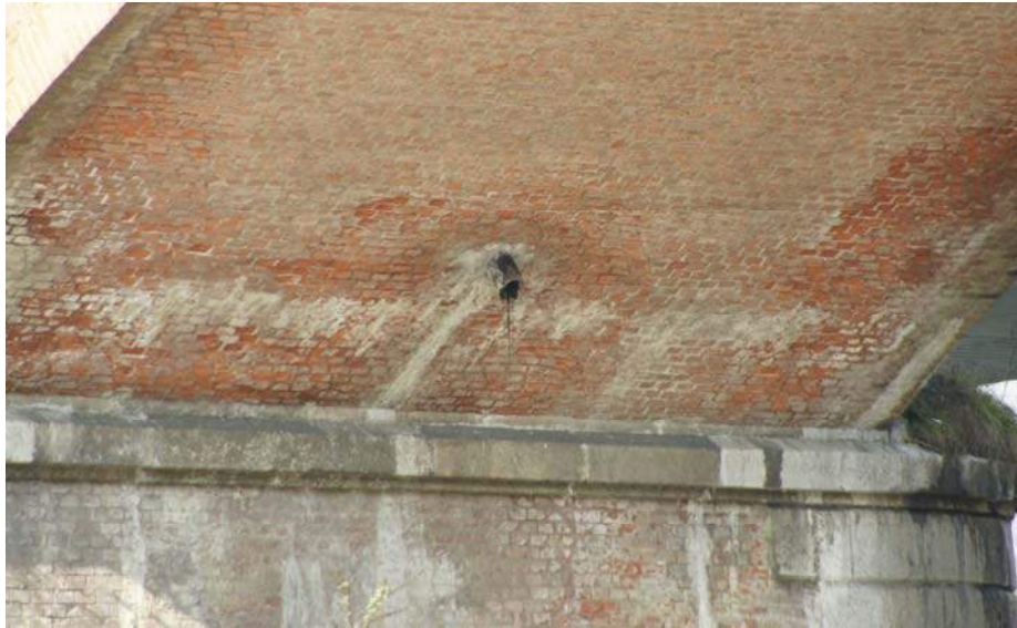
Fig. 2.2.3 – Doccione di scarico delle acque.
