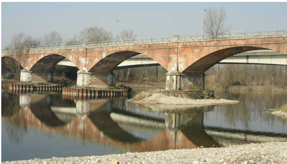
Fig. 2.2.1 – Vista d'insieme del ponte.
