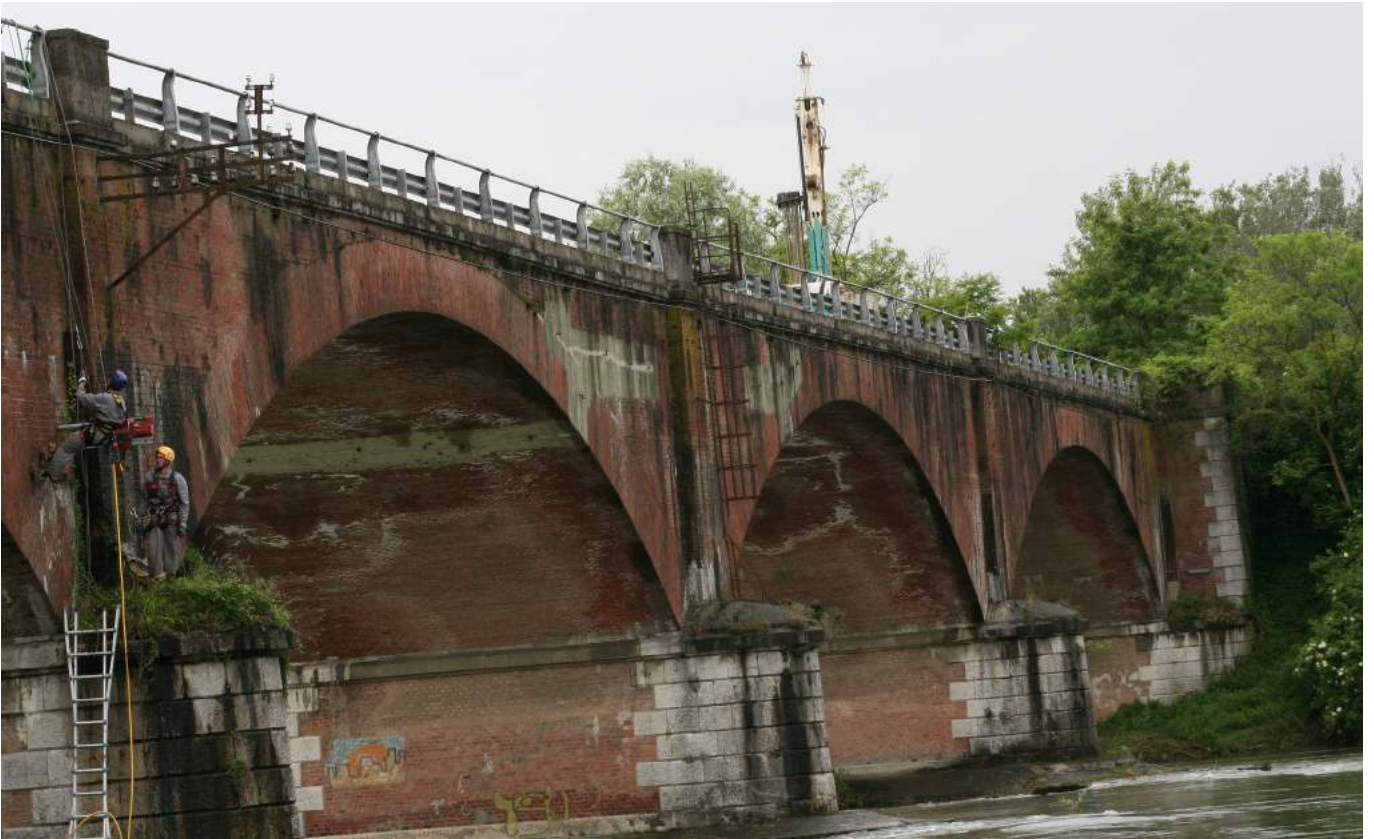
Fasi di esecuzione del carotaggio C2 e del sondaggio S1
