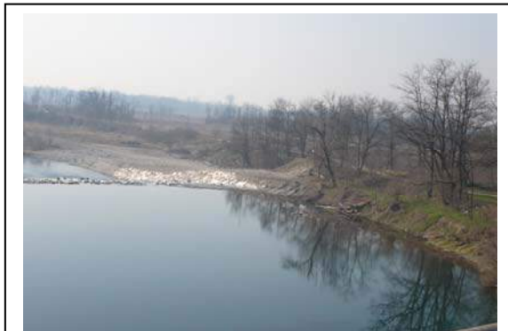
Sponda in destra idraulica a valle del ponte storico
