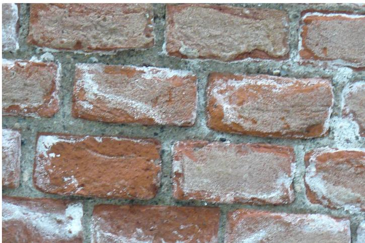
Il paramento murario e le strutture voltate sono in laterizio che, secondo i documenti, provengono dalla fornace locale di Zelo Buon Persico.
