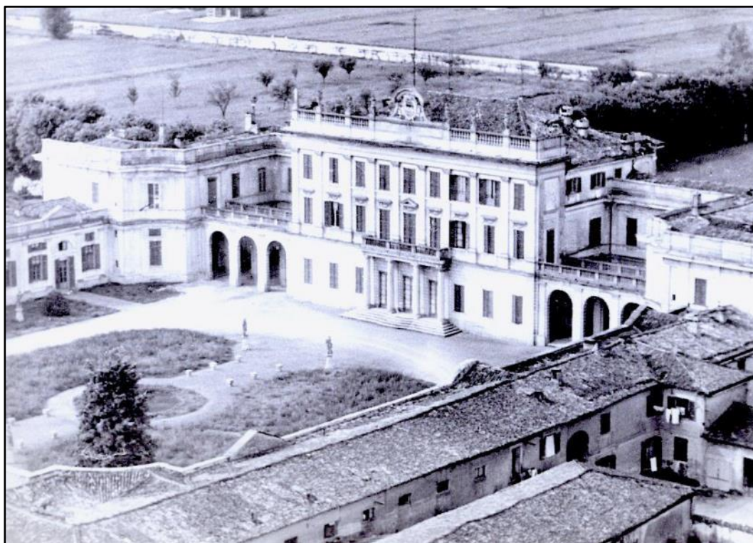
Figura 4.9.1c Vista aerea: Villa Borromeo
