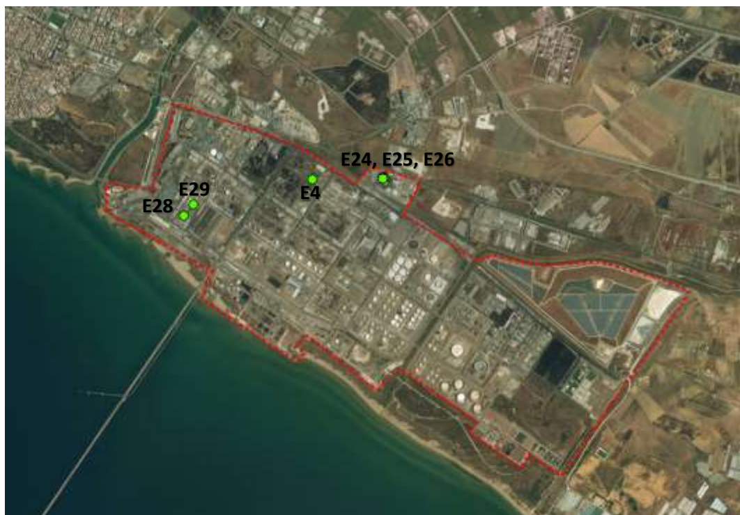
Figura 5-3 Localizzazione dei camini in funzione nel 2018 rispetto al confine dello stabilimento (in rosso)
