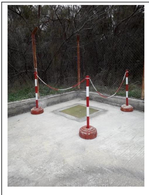
4) All'interno di tale pozzetto verrà installata una pompa sommersa dotata di galleggiante che si attiverà non appena sarà rilevata la presenza di acqua all'interno dello stesso. Tali acque saranno raccolte all'interno di IBC da 1 m<sup>3</sup> ed avviate, previa attività di classificazione e caratterizzazione ai sensi della parte quarta del D.Lgs. 152/06, a idonei impianti terzi di trattamento.
