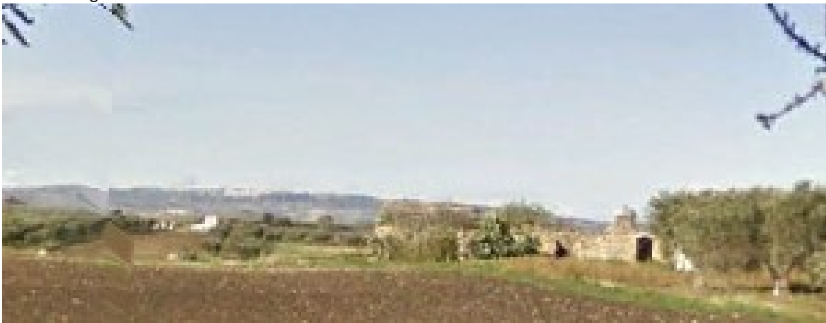
Rudere con il tetto crollato
