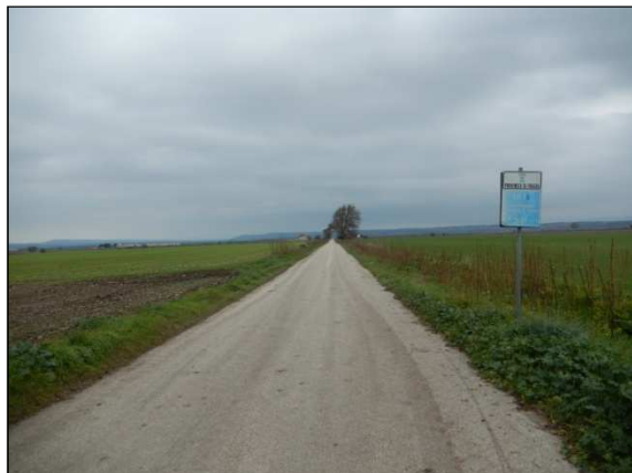
33. Elettrodotta lungo la SP 15, da SP 8, località Mass. Ruta
