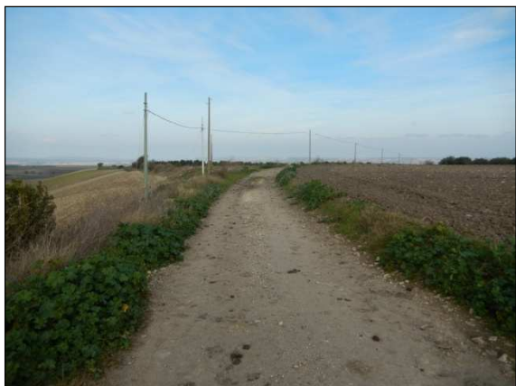
48. Elettrodotto in direzione della turbina 6, località Mass. Tufarolo
