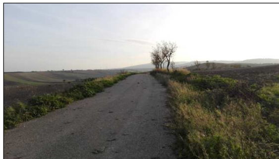
64. Elettrodotto lungo la Strada Vicinale della Scurgola da Mass. Andreani in direzione della turbina 7
