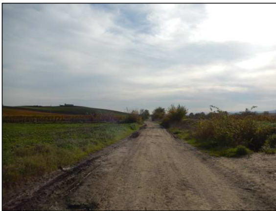
19. Elettrodotto da SP 11 verso SP 9, località P.te del Porco
