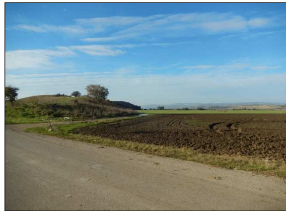
2. Elettrodotto in direzione della stazione elettrica, località Rascitore
