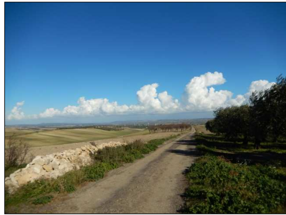
91. Elettrodotta lungo la Strada Vicinale Mezzana dei Marchi, località Mass. la Mezzana
