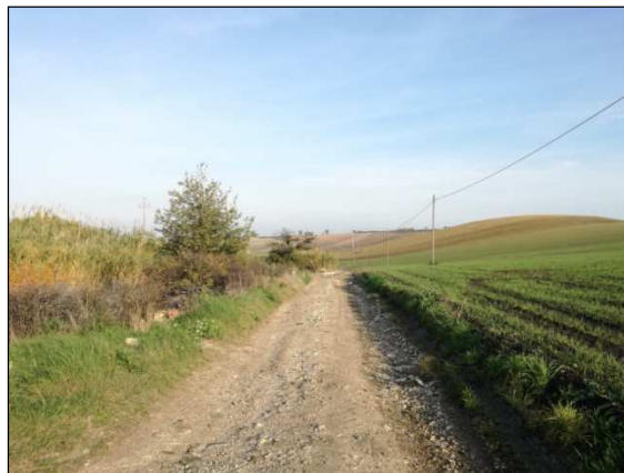
58. Elettrodotto in località Erba Bianca in direzione del canale dell' Arciprete
