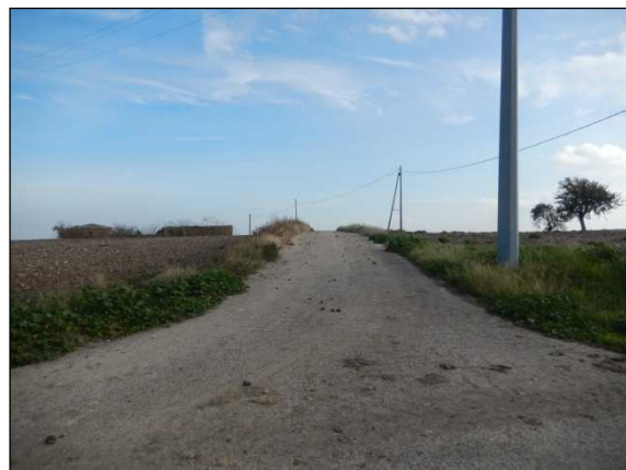
50. Elettrodotto in direzione della turbina 5, località Mass. Tufarolo
