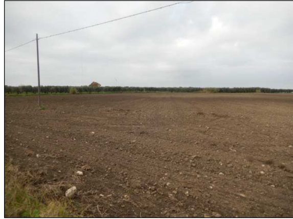
39. Elettrodotto interno in direzione della turbina 6, località Piano di Refe
