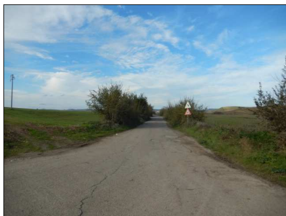
18. Elettrodotta lungo la SP 9, località P.te del Porco
