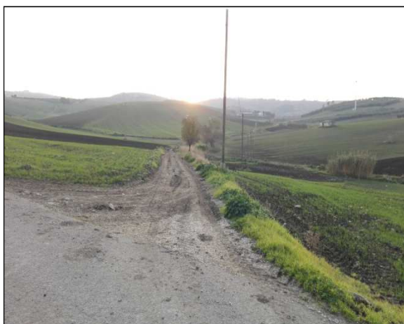
69. Elettrodotto in direzione della turbina 4, località Erba Bianca
