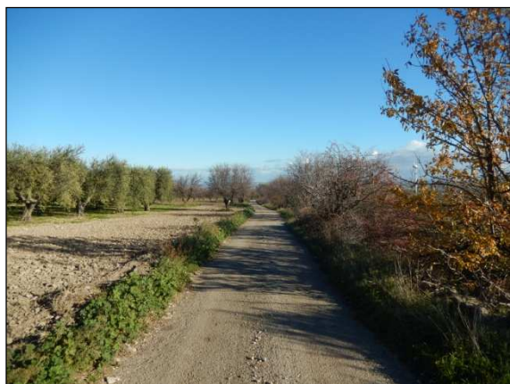
74. Elettrodotta lungo la Strada Vicinale Santa Lucia, località Piano della Vedova
