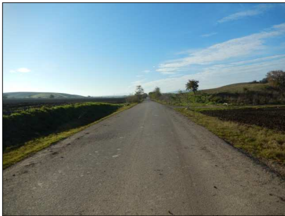
1. Elettrodotto lungo la SP 9, località Rascitore
