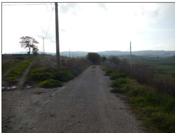
49. Elettrodotto in direzione della turbina 4, località Mass. Tufarolo
