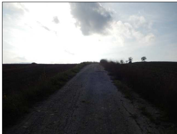
52. Elettrodotta in località Mass. De Salvia in direzione della turbina 3
