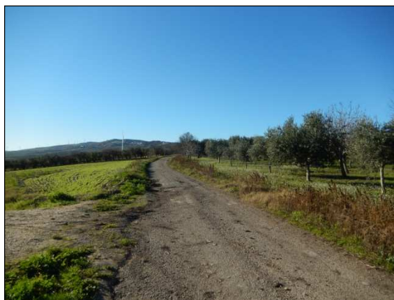
75. Elettrodotta lungo la Strada Vicinale Santa Lucia, località Mass. Calzone
