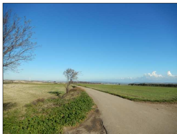
77. Elettrodotta lungo la Strada Vicinale Santa Lucia, località Mass. Celozzi , in direzione della turbina 6
