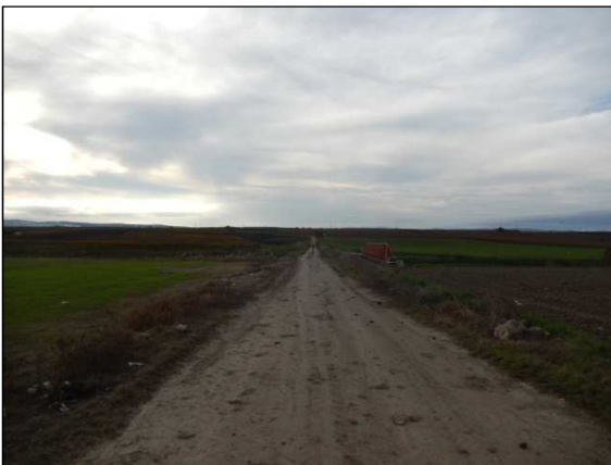
22. Elettrodotto lungo la SP 15, in direzione del Torrente Staina, località Voiragni
