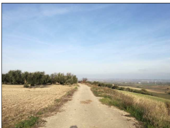
55. Elettrodotta dalla turbina 3 in direzione della turbina 5, località Mezzana di Marco
