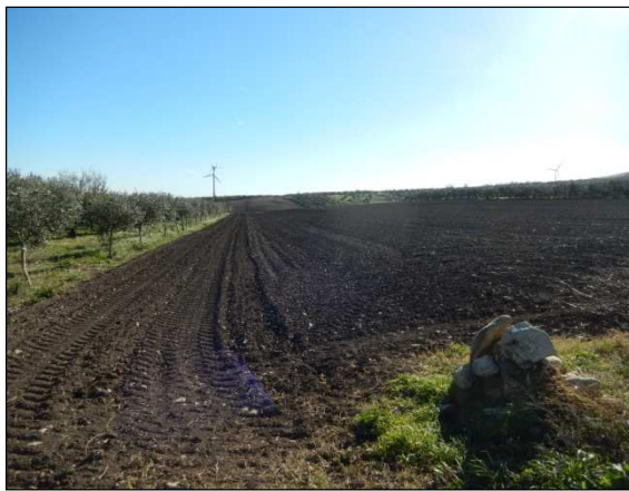
92. Elettrodotta interno in direzione della turbina 2, località Mass. la Mezzana
