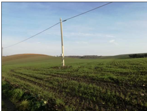
59. Elettrodotto interno in direzione della turbina 4, località Erba Bianca
