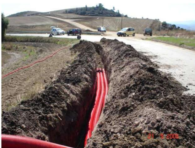
Fig. 1.2 - Foto illustrativa della messa in posa dei cavidotti MT
