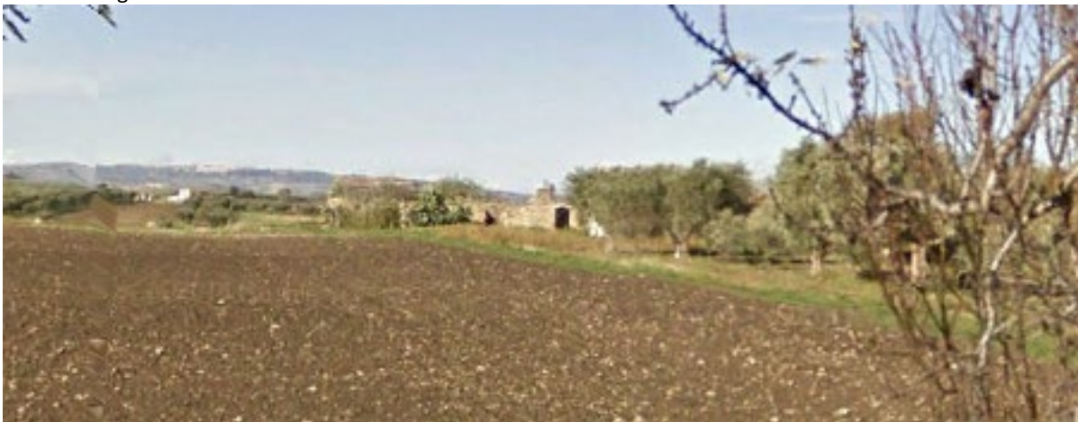
Rudere con il tetto crollato
