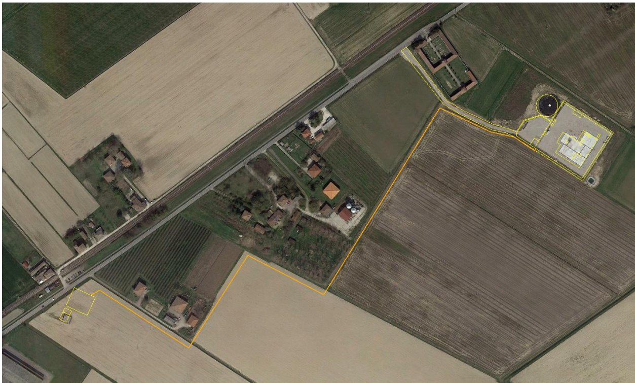
Figura A.5.1: Area pozzo, condotta di allaccio alla SNAM Rete Gas.
