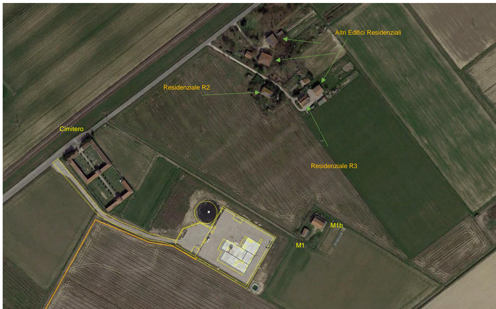
Figura 13 – Area pozzo e dettaglio localizzativo dei ricettori.
