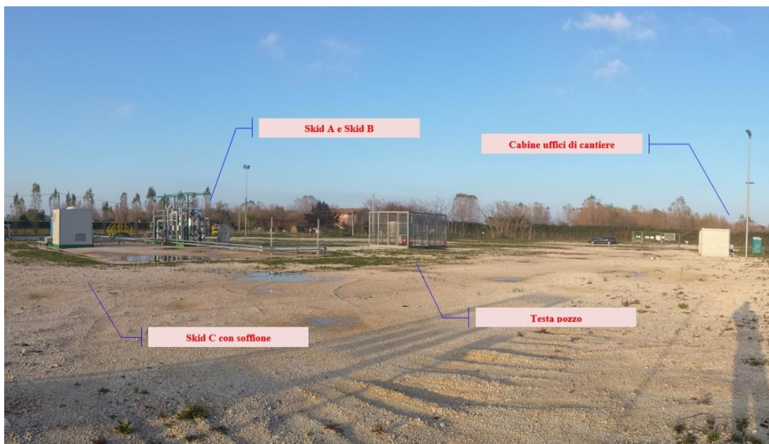
Figura 7 – Esempio di impianto analogo all'impianto di progetto (1/3).
