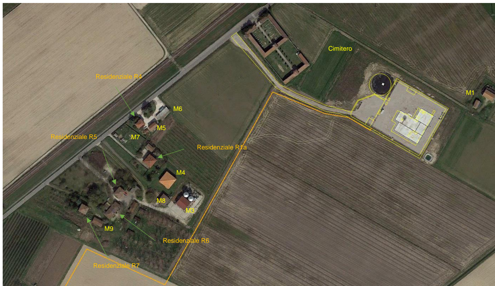
Figura 12 – Area pozzo e dettaglio localizzativo dei ricettori.
