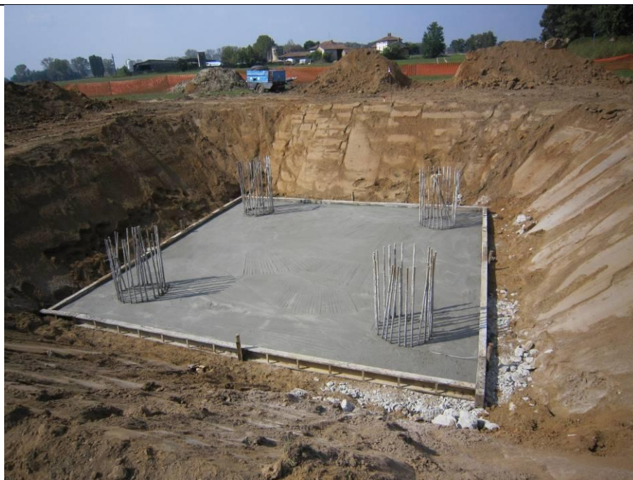
Figura 22 - Realizzazione di una fondazione su pali trivellati per un sostegno monostelo. Nell'immagine si può osservare una fondazione in fase di realizzazione. Si possono distinguere facilmente i quattro pali trivellati già realizzati e gettati (si osservano le "ripresе" delle quattro gabbie metalliche) ed il piano di "magrone" sul quale impostare il monoblocco in cls
