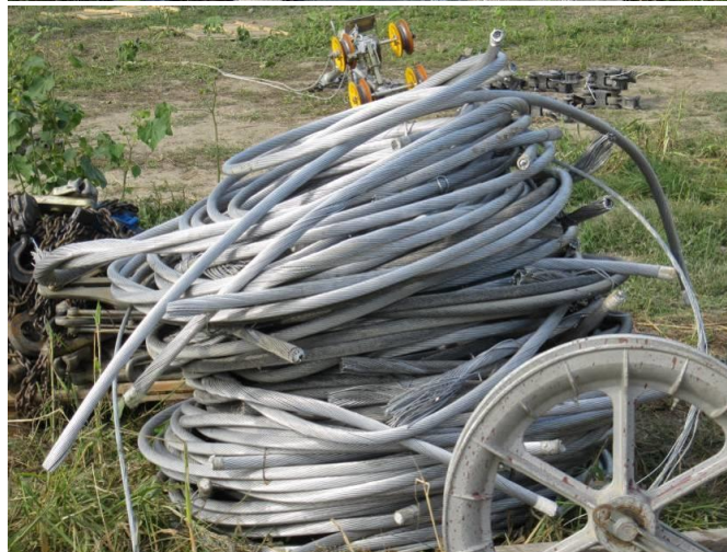
Figura 38- Fasi demolizione di un sostegno a traliccio, particolare di materiale raccolto
