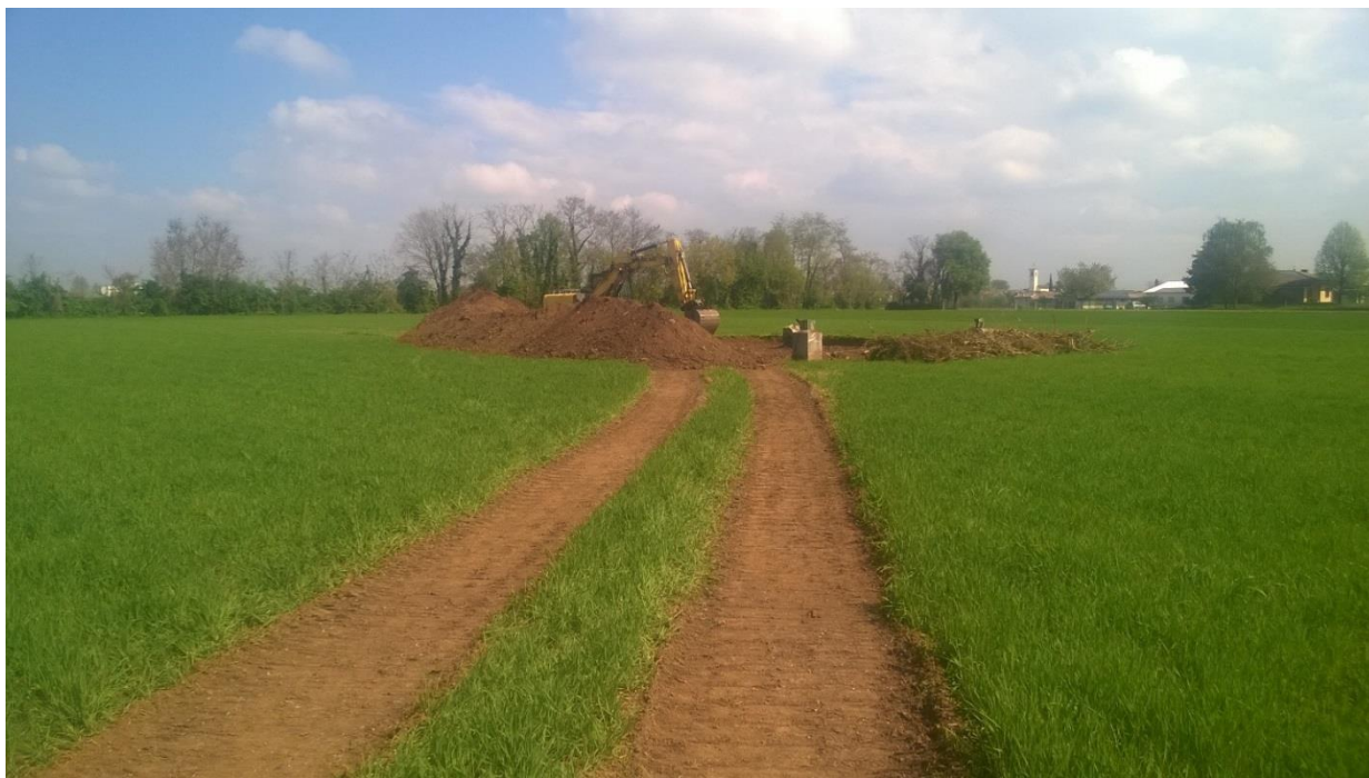
Figura 41- Esempio di pista temporanea su terreno agricolo
