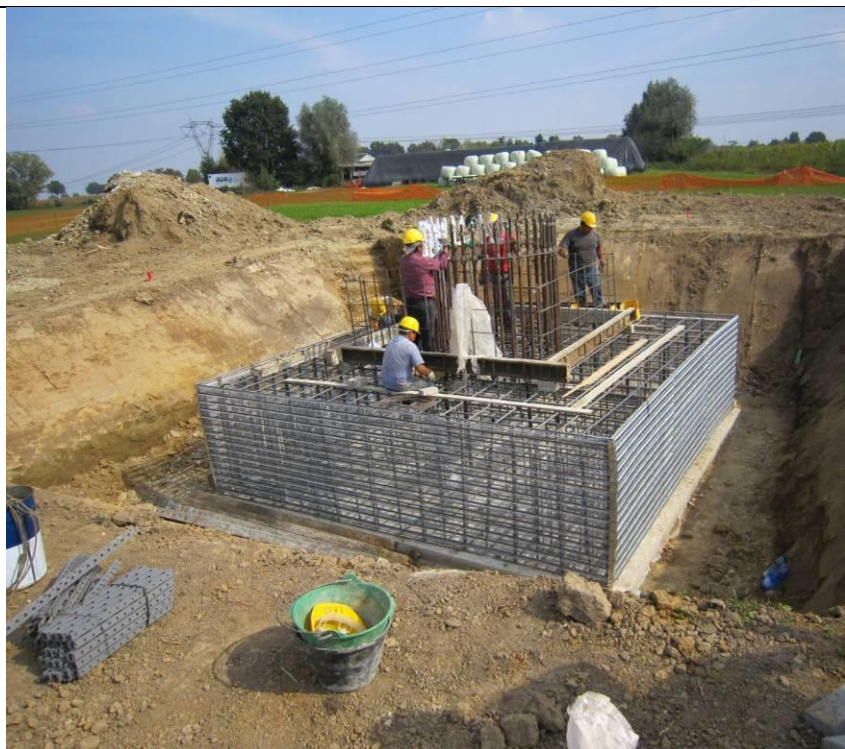
Figura 16 - Realizzazione di fondazione superficiale tipo plinto a monoblocco per un sostegno monostelo.
