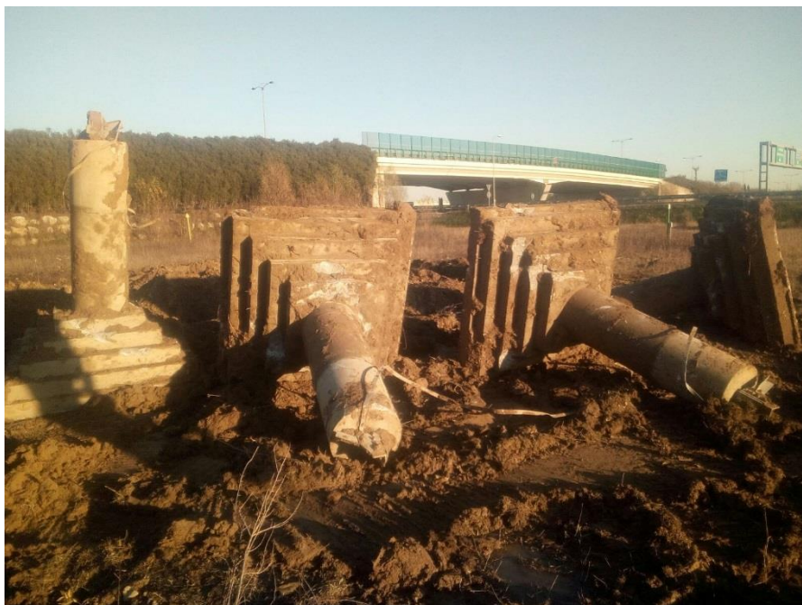
Figura 39 - Esempio di rimozione della fondazione superficiale di un sostegno 220 kV
