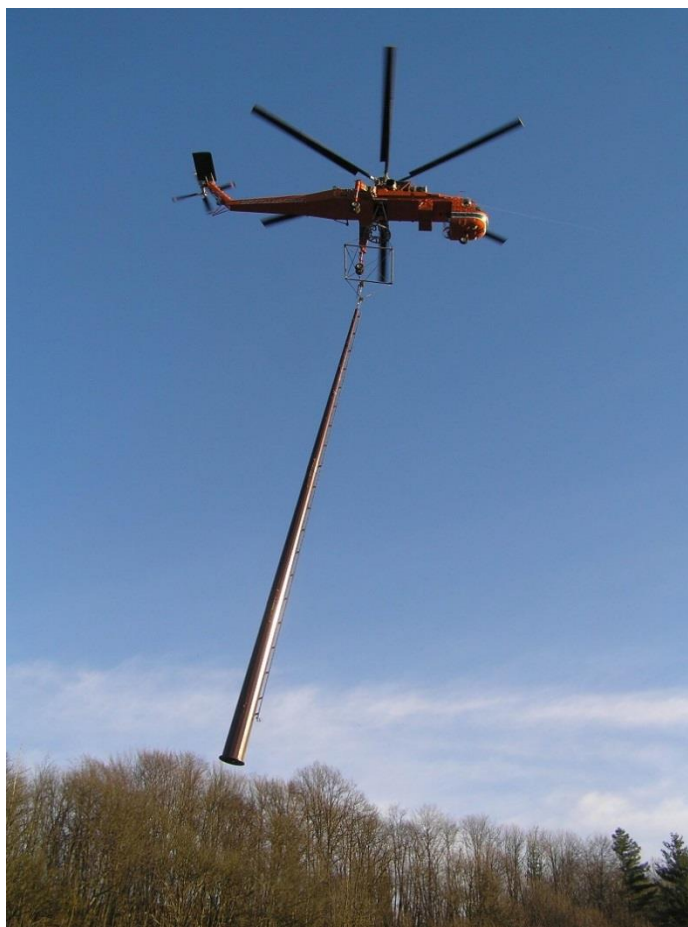
Figura 33 - Trasporto di un sostegno con elicottero Erickson
