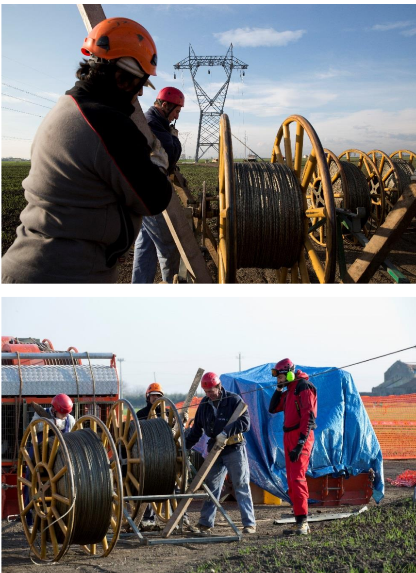
Figura 36 - Fasi di tesatura della linea elettrica
