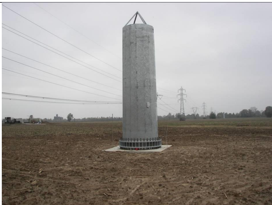
Figura 18 - Realizzazione di fondazioni superficiali tipo plinto a monoblocco per un sostegno monostelo.
