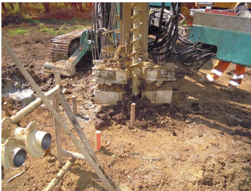
Figura 26 - Macchina operatrice per la realizzazione di micropali tubfix; sistema di scavo mediante trivella elicoidale
