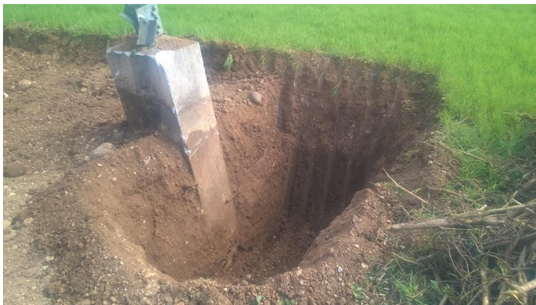
Figura 40 - Esempio rimozione della fondazione superficiale di un sostegno 380 kV ST
