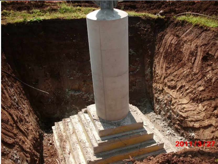
Figura 13 - Realizzazione di fondazioni superficiali tipo CR per un sostegno a traliccio. Nell'immagine si può osservare una fondazione CR appena "scasserata". Si possono distinguere facilmente la parte inferiore a parallelepipedo tronco piramidale ed il colonnino di raccordo con la "base" del sostegno
