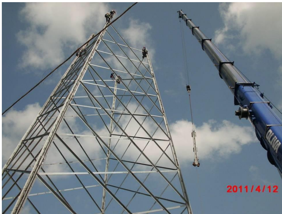
Figura 28 - Fasi di montaggio sostegno a traliccio
