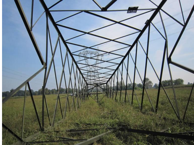
Figura 37 - Fasi demolizione di un sostegno a traliccio
