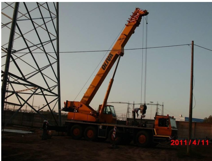
Figura 29 - Fasi di montaggio sostegno a traliccio
