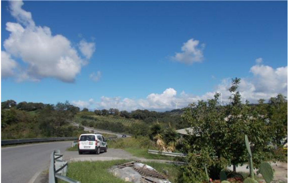
Figura 39- Stato attuale: vista in prossimità del sostegno di nuova realizzazione n.7
