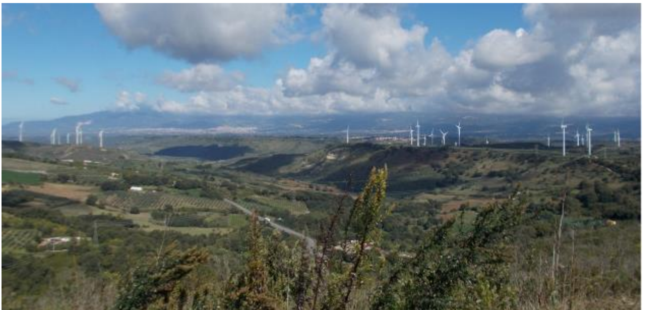
Figura 38- Stato futuro: vista dell'area di installazione dei sostegni di nuova realizzazione n.6, 7 e 8
