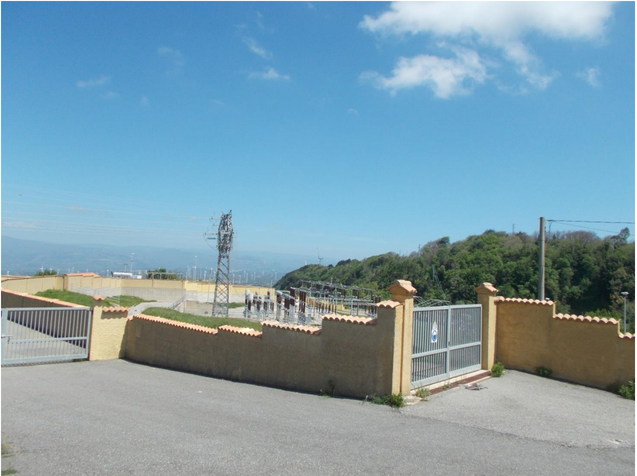
foto 10-Accesso all'area destinata alla realizzazione del nuovo Palo Gatto "PG", interna alla SE di Girifalco
