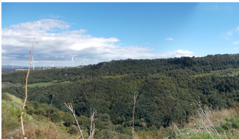
Foto 3 Punto di ripresa 2A: panoramica dell'area di ubicazione dei sostegni in progetto n. 2, 3 e 4 (in rosso la presenza di un parco eolico; in viola la presenza di tralicci)
