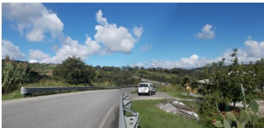
Foto 7 Punto di ripresa 3B: vista sull'area di ubicazione del sostegno in progetto n.7
