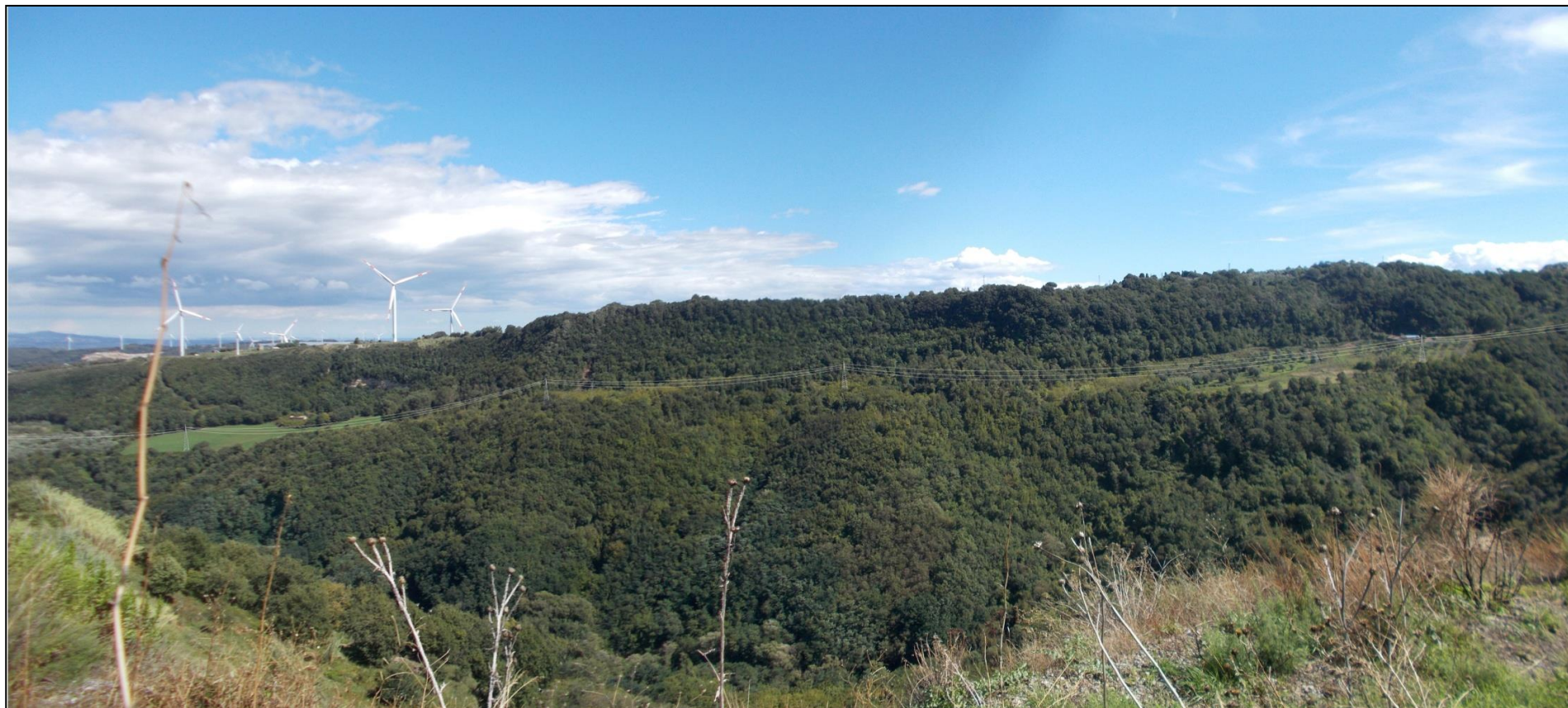
Foto9_ Stato futuro: vista (punto di ripresa fotografica P1) dell'area di installazione dei sostegni di nuova realizzazione n.1, 2, 3 e 4
