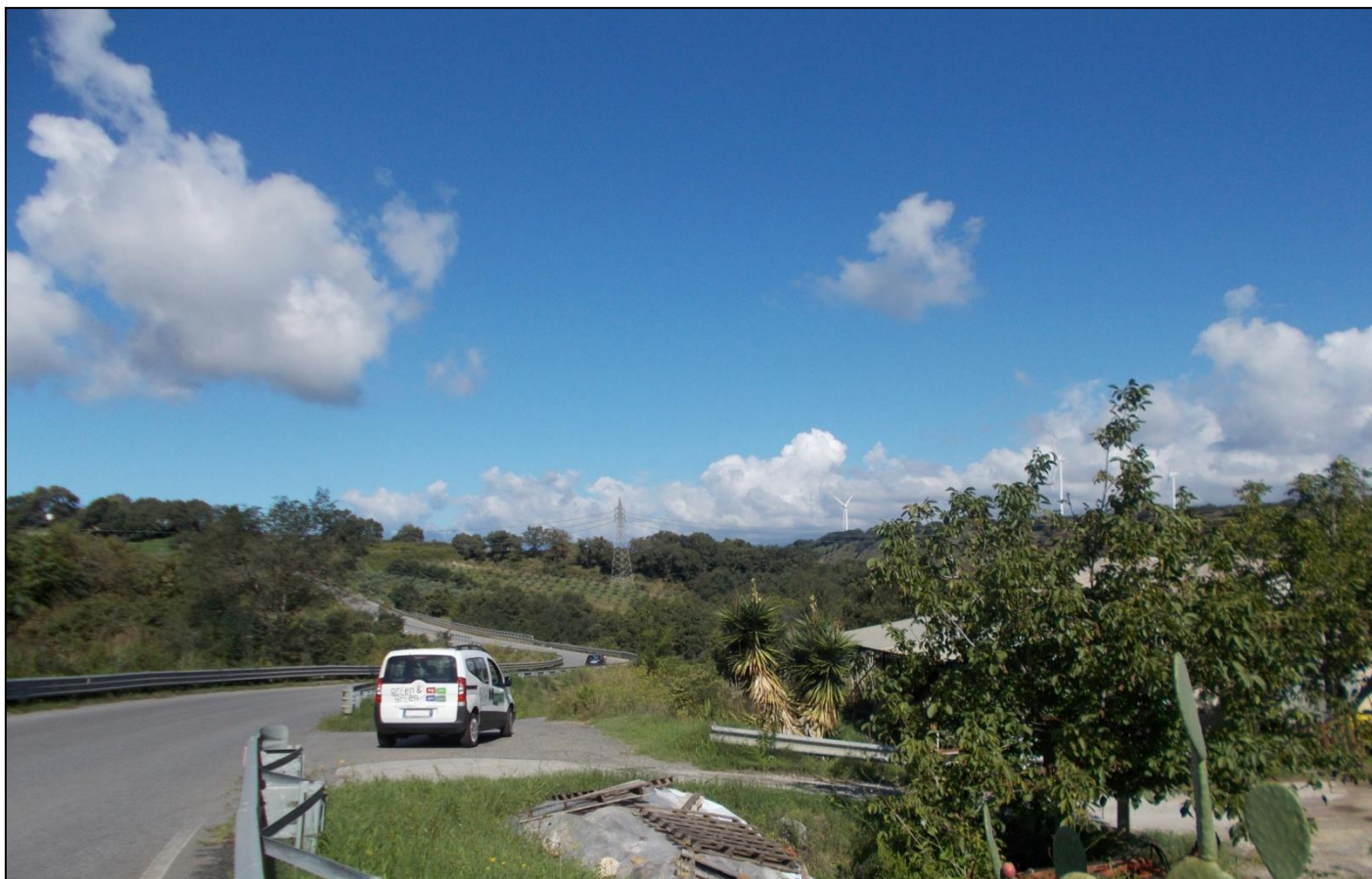
Foto 13_ Stato futuro: vista (punto di ripresa fotografica P3) in prossimità del sostegno di nuova realizzazione n.7
