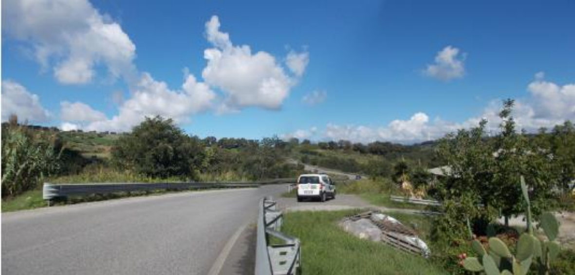
Foto4_Punto di ripresa 3B: vista sull'area di ubicazione del sostegno in progetto n.7
