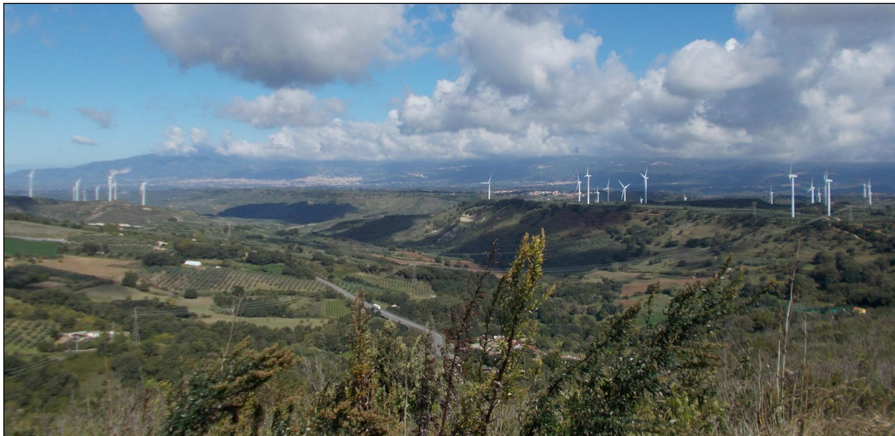
Foto11_ Stato futuro: vista (punto di ripresa fotografica P2) dell'area di installazione dei sostegni di nuova realizzazione n.6, 7 e 8
