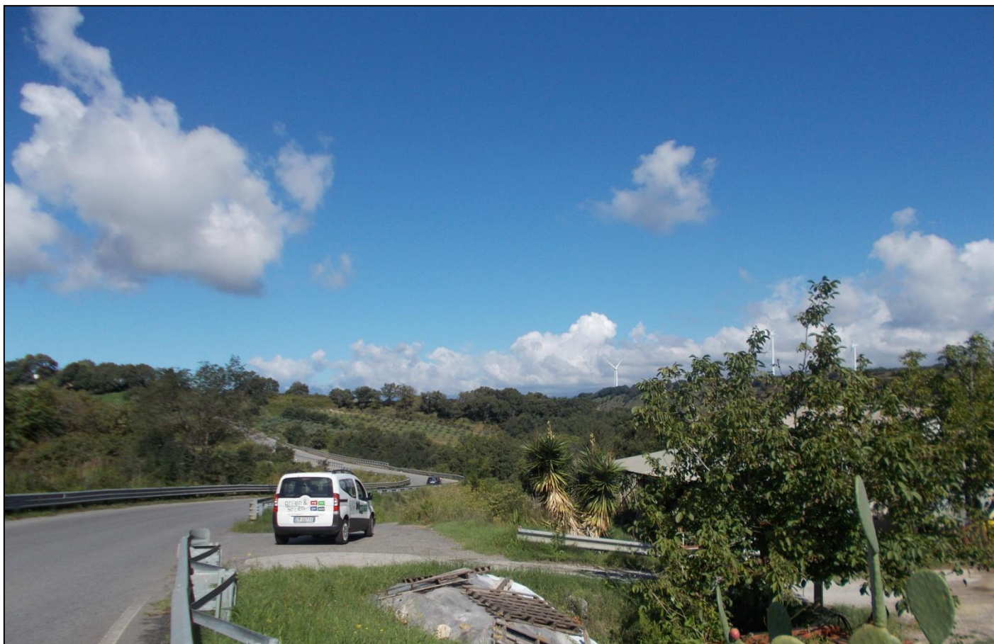
Foto 12_Stato attuale: vista (punto di ripresa fotografica P3) in prossimità del sostegno di nuova realizzazione n.7
