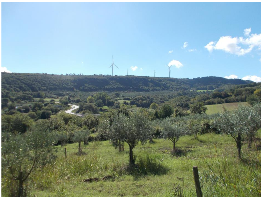
Foto 1: Area tra sostegni 5-6
