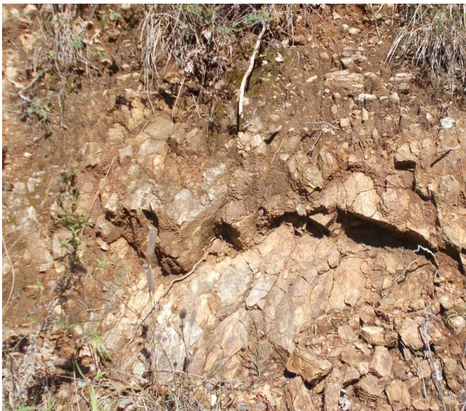
Foto 6: Affioramento fortemente degradato ed alterato di porzioni dell'Unità di Castagna, in prossimità del sostegno n°7
