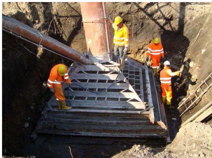
Figura 33: - Esempio di realizzazione del piede di fondazione
