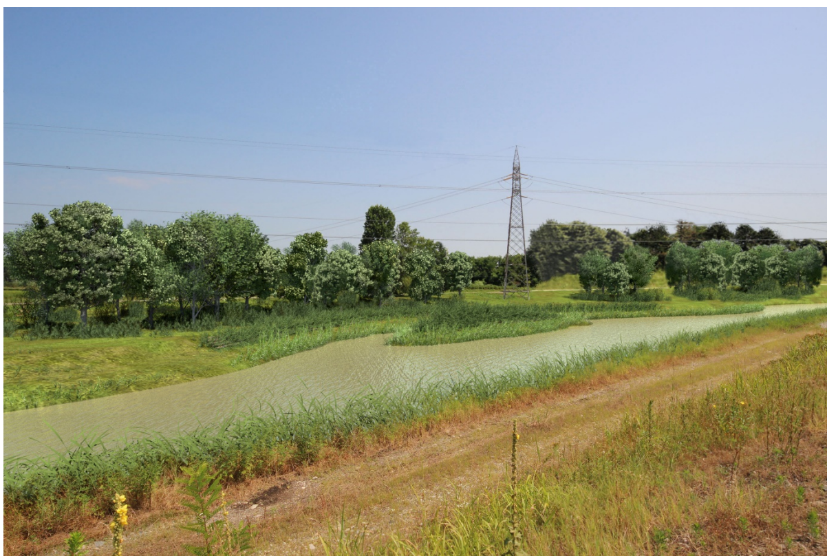
Figura 4.4: area mediana del tratto di Roggione interessato dall'intervento – Post Operam
