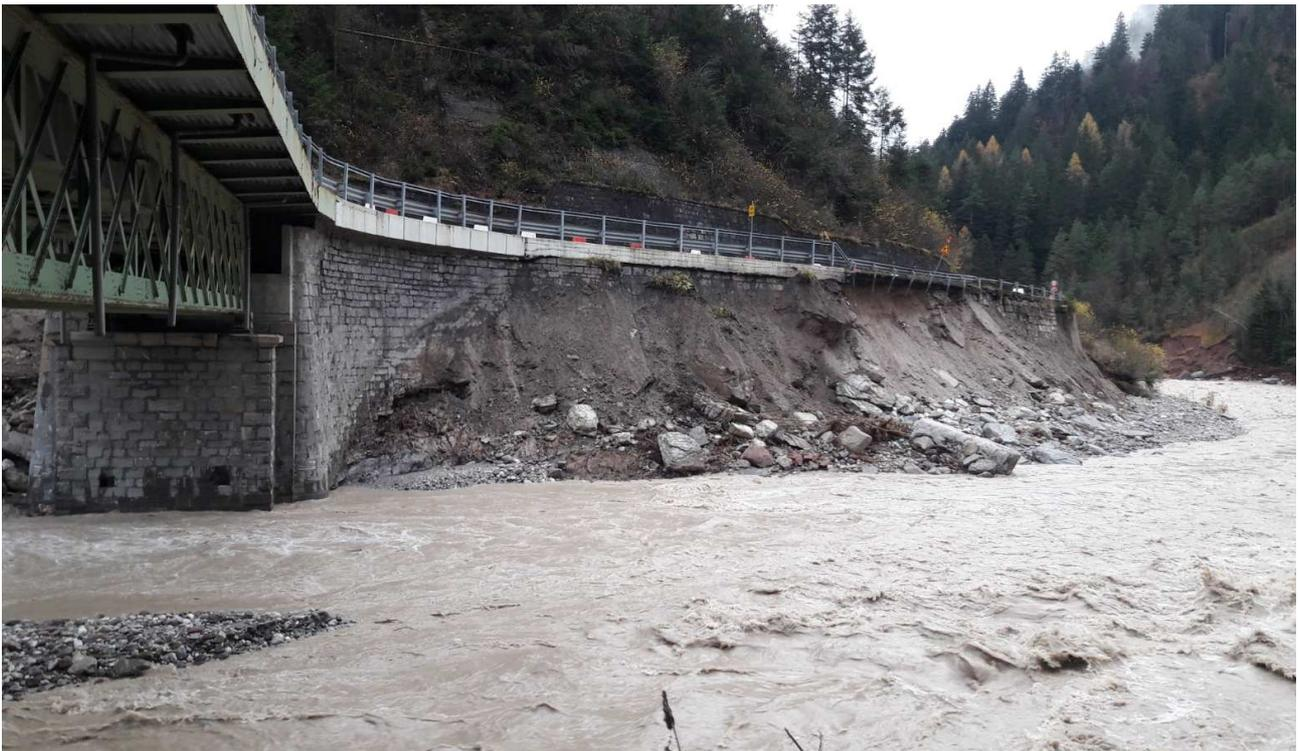
**Figura 14a – Fenomeni erosivi in prossimità del ponte esistente**
