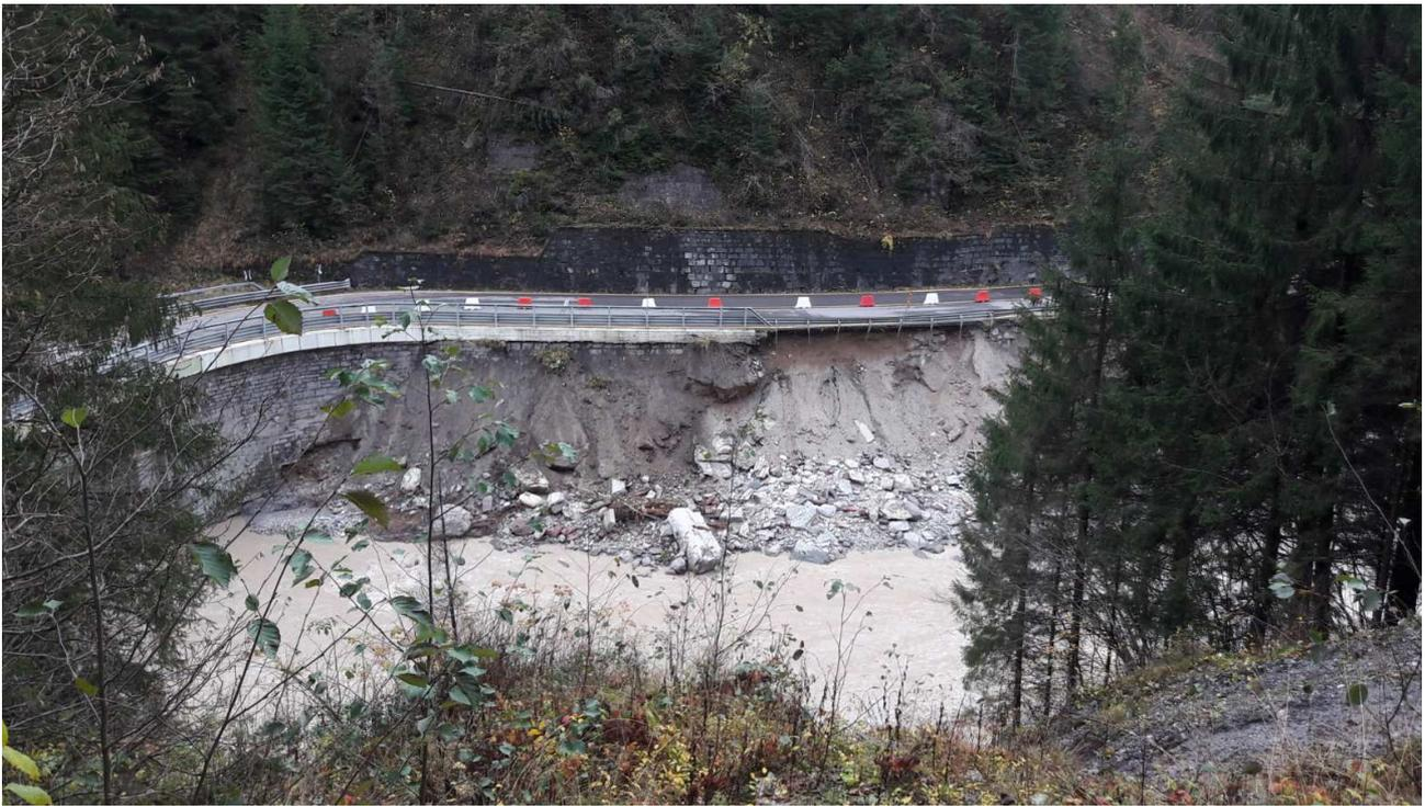
**Figura 14b – Fenomeni erosivi in prossimità del ponte esistente**
