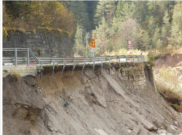
**Figura 14d – Danneggiamenti al corpo stradale sulla S.S. 52**
