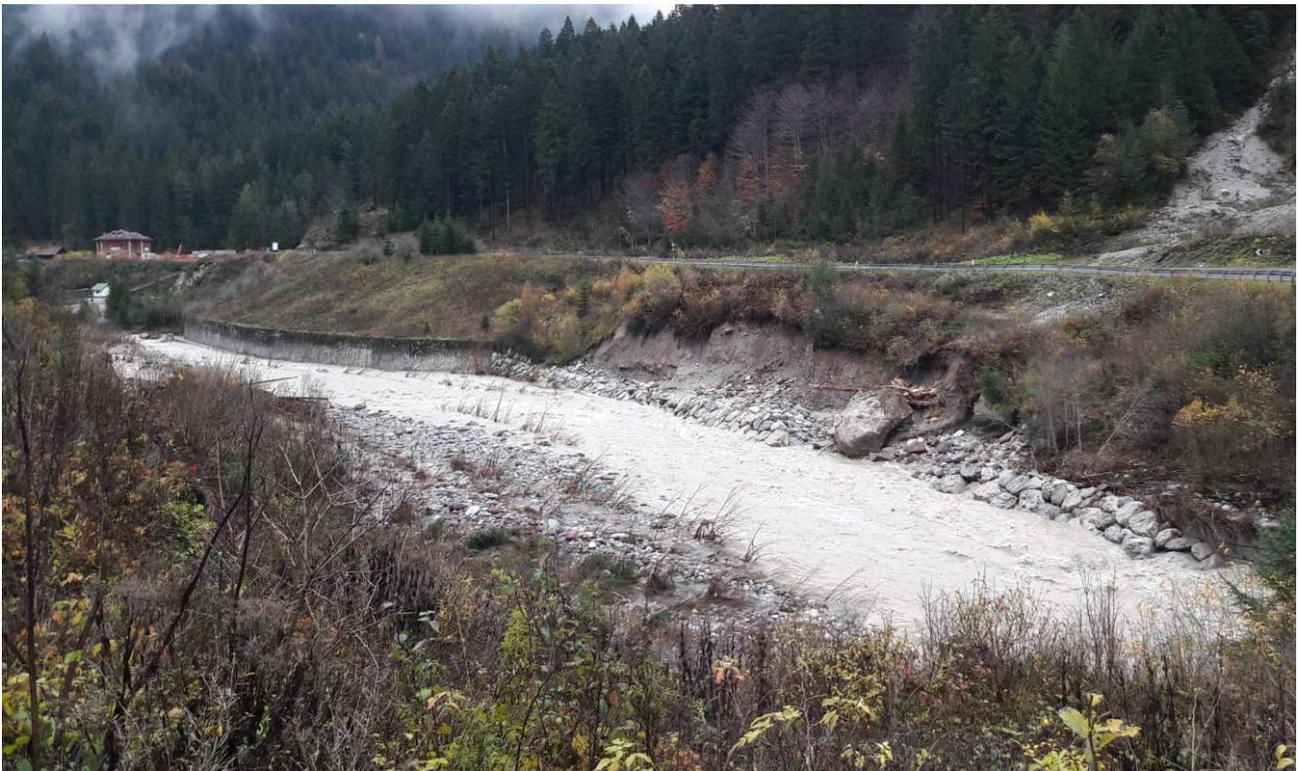
**Figura 14c – Fenomeni erosivi in prossimità del ponte esistente**
