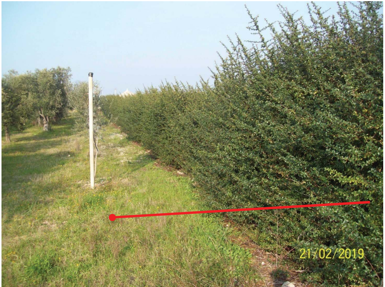
Foto n. 3: Panoramica del punto di consegna del gas
