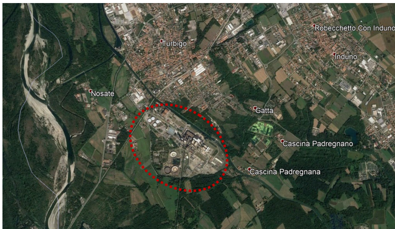
Figura 1/1 – Localizzazione della centrale termoelettrica di Turbigo (MI)
